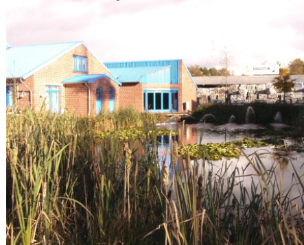
Regenrückhaltung der Privaten
