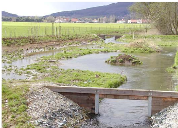
Renaturierungsmaßnahmen an der Haller
