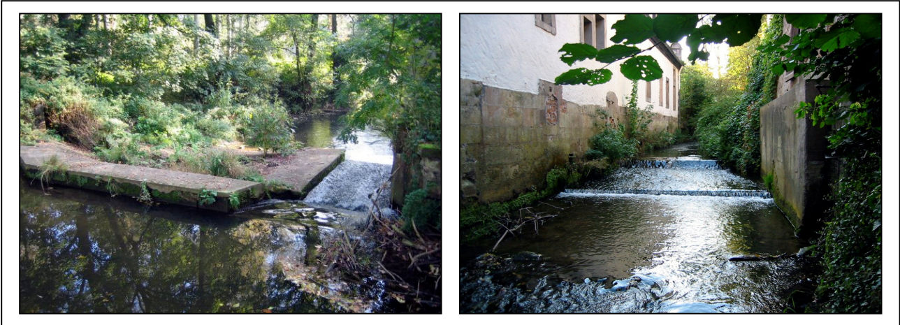
Abbildung 7-22: Wehr (links) und Verbau im Mühlenkanal (rechts) in Hasperde (GEUM.tec 2006)
