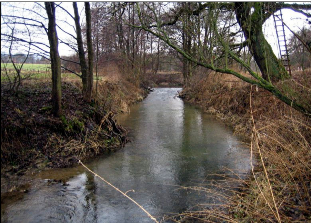
Abbildung 7-20: Eingeriefener Hamelabschnitt mit standortgerechtem Gehölzbestand oberhalb von Hachmühlen, etwa auf der Höhe des Deisterbahnhofs (GEUM.tec 2006)
