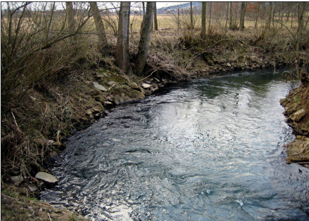
Abbildung 7-17: Steinschüttung im Böschungfußbereich einer Mäanderaußenseite (ca. 500 Meter oberhalb von Groß Hilligsfeld) (GEUM.tec 2006)
