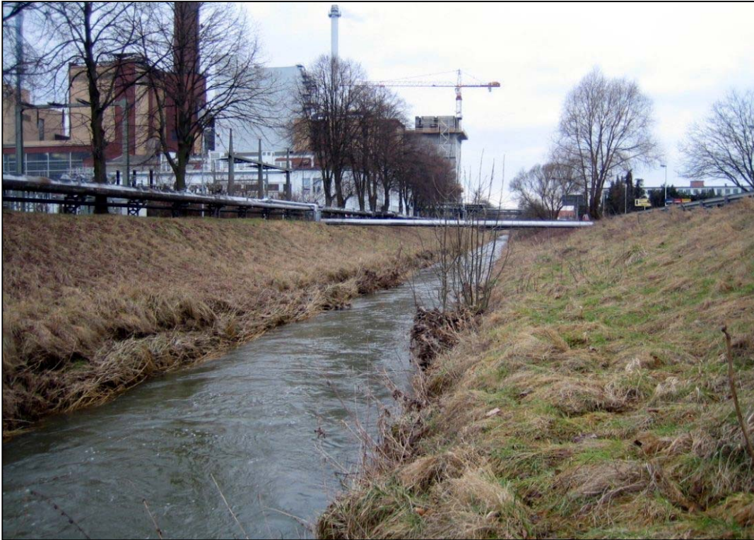
Abbildung 7-28: Fluthamel im Bereich des Elektrizitätswerks Wesertal in Hameln (GEUM.tec 2006)
