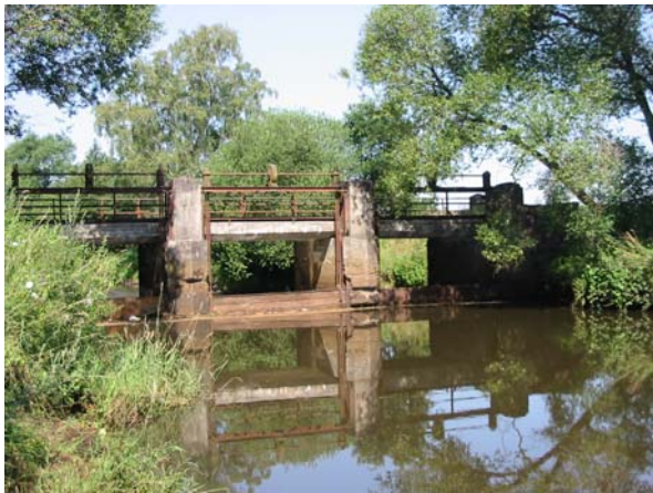
Abbildung 24: Stauanlage bei Ahausen (Wümme-km 56+730/24+970)
