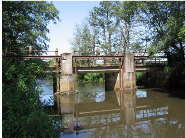
Abbildung 39: Schleuse V bei Hellwege (km 52+970/21+162)
