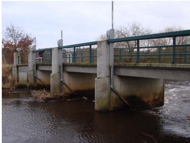
Abbildung 41: Klappenwehr Hellwege (km 56+730/24+970)
