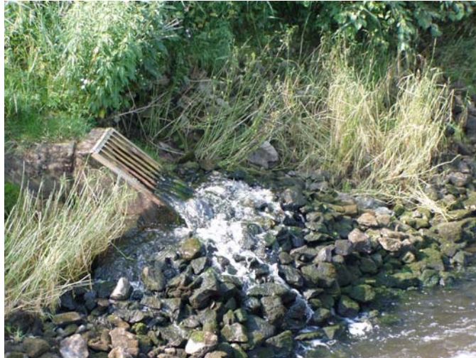
Abbildung 26: Einleitung aus der Kläranlage Rotenburg in die Wümme (km 65+500/33+680)
