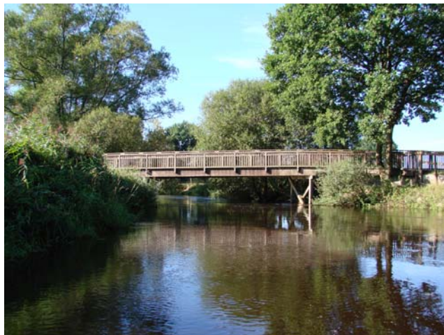
Abbildung 60: Holzbrücke - Blick flussabwärts (km 68+185/36+405)
