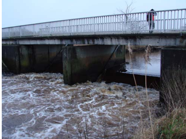
Abbildung 56: Klappenwehr Unterstedt - Blick flussaufwärts (km 65+500/33+680)
