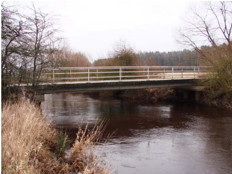
Abbildung 23: Stahlbetonbrücke bei Wümme-km 61+051/29+271
