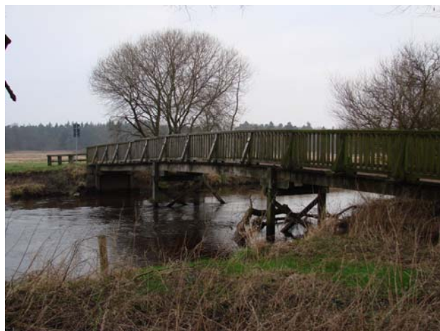
Abbildung 58: Holzbrücke - Blick flussabwärts (km 67+280/35+512)
