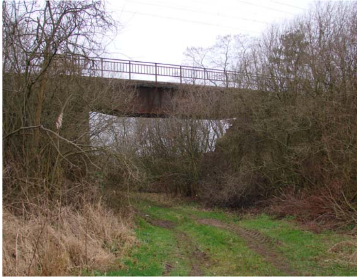
Abbildung 22: Eisenbahnbrücke bei Wümme-km 64+370/ 32+600
