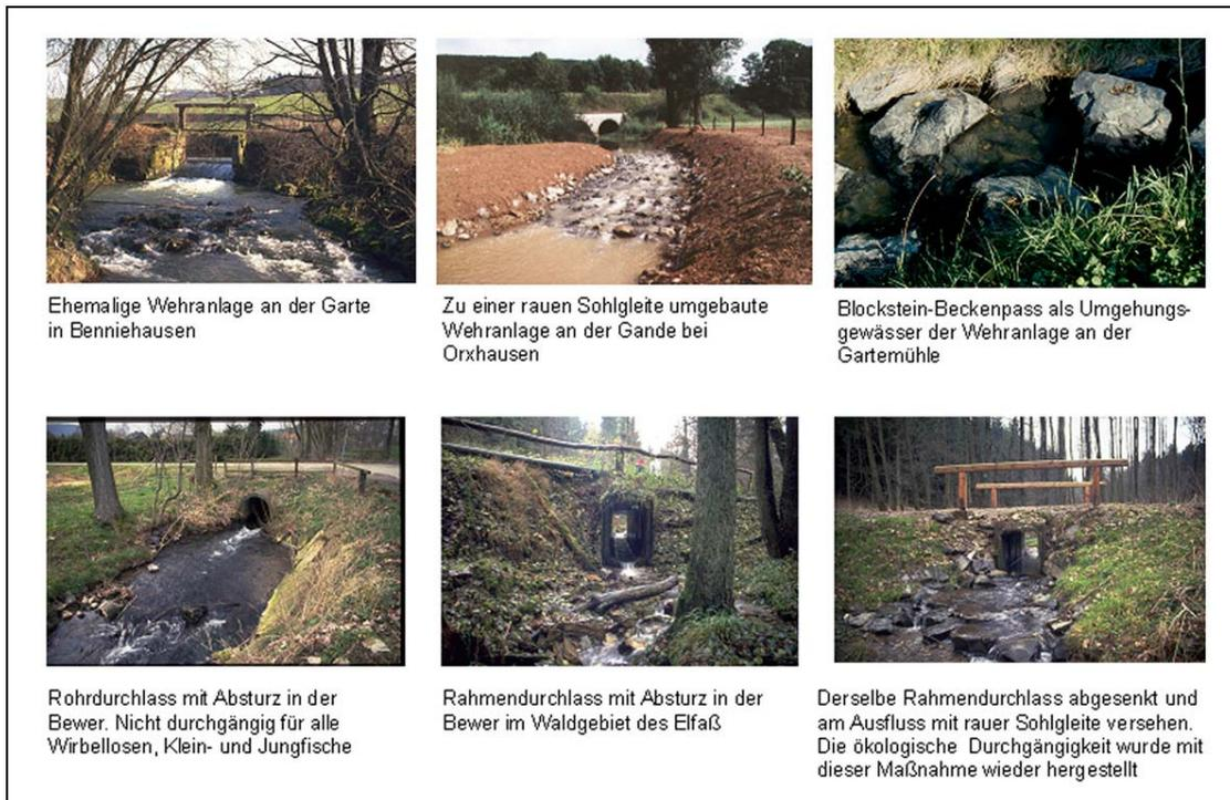
**Abb. 3.12: Beispiele für Querbauwerke mit Absturz und Maßnahmen zur Wiederherstellung der ökologischen Durchgängigkeit durch den Leineverband**
