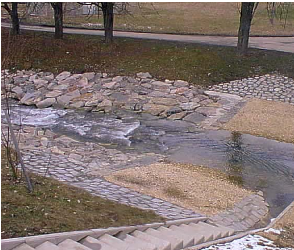
Abbildung 4: Bildübertragung von einer Messanlage mit Fließwechsel an einer rauhen Rampe
