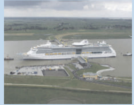
Emssperrwerk bei Gandersum (Foto: NLWKN) Eemsafluiting naar Gandersum
