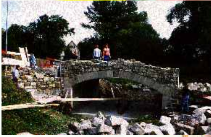
Die erneuerte Flutmuldenbrücke bei der Moritzmühle
