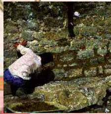
Sanierung der Wassermauern im Stadtbereich
