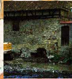
Unterfangung der unterspülten Gebäude an der Streu
