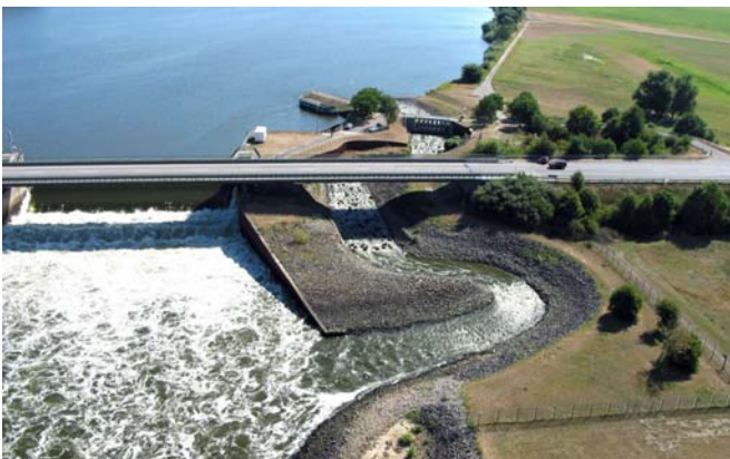
Für die Ökologie der Elbe von herausragender Bedeutung ist der Bau einer zweiten Fischwechsellanlage am Wehr Geesthacht. Die Errichtung einer Wasserkraftanlage in diesem Wehr hätte katastrophale Auswirkungen auf die Fischfauna im gesamten Elbeinzugsgebiet. Foto: Wassergütestelle Elbe
