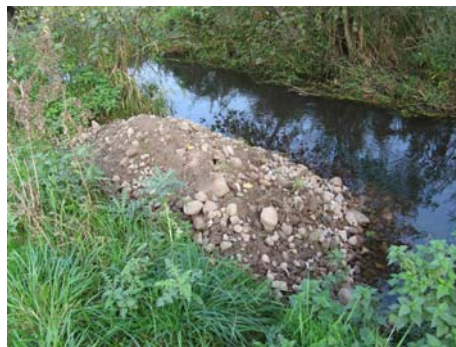
Kiesschüttung als Seiteneinengung im Staersbach
