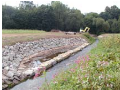
(3) Konventionelle Bauweise mit Steinsatz
