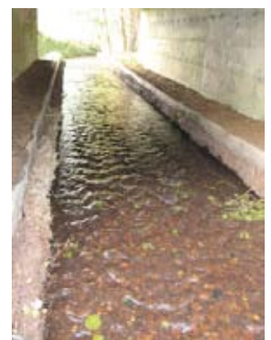
(2) Passierbarkeit für Wasser- und Landorganismen unter der Este-Brücke bei Welle an der B3.
