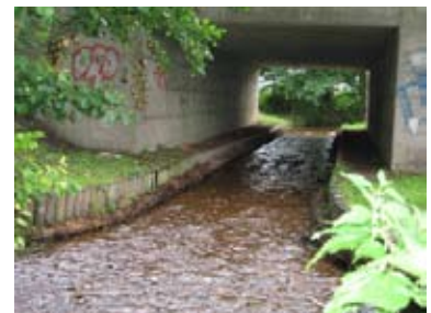
(8) Eine raue Kieselsohle und beidseitige Bermen verbessern die Passage unter einer Brücke
