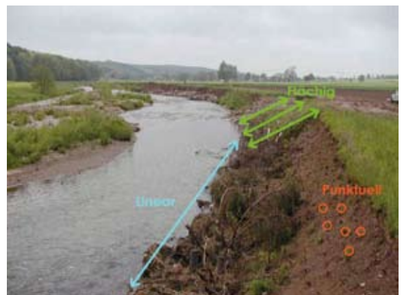
(2) Auswahl der Bauweisen entsprechend Schutzziel und Wirkungsweise
