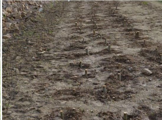
Foto 19: Durch ingenieurbiologische Bauweisen lassen sich standortgerechte Gehölzbestände auf einfache Weise etablieren. Hier werden Steckhölzer genutzt. (Foto: STOWASSERPLAN)
