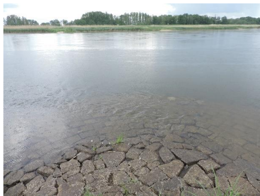
Foto 2: Blick auf Uferbefestigung. (Foto: STOWASSERPLAN)
