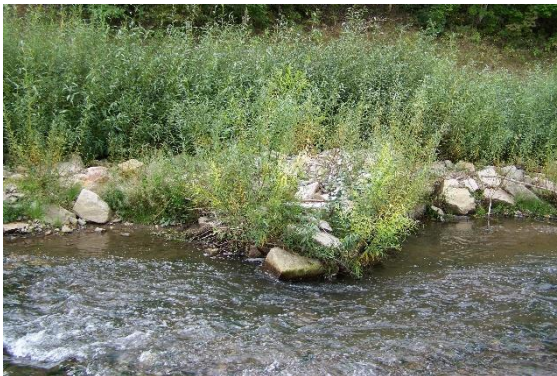
Foto 35: Links und rechts der Buhne erkennt man am strömungsbild, dass das Wasser kaum fließt und Ruhezonen entstehen. (Foto: STOWASSERPLAN)
