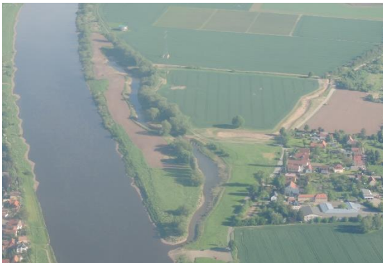
Foto 37: Wiederherstellung eines Elbseitenarmes, Luftaufnahme kurz nach Baufertigstellung (Foto: STOWASSERPLAN)
