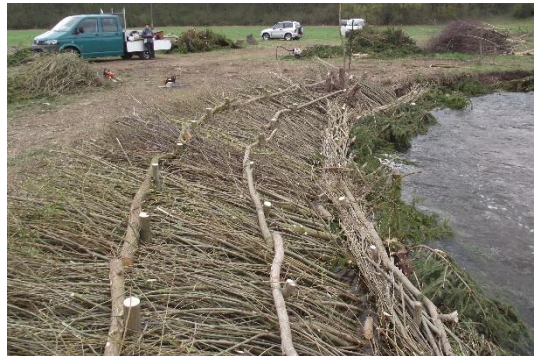
Foto 12: Spreitlage sind eine sehr stabile und effektive Ufersicherung. Sie begründen dichte Uferweidenbestände. (Foto: STOWASSERPLAN)
