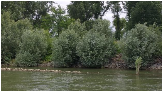
Foto 28: Die Kombination von längsgerichteten und quer zur Strömung ausgerichteten Elementen sind bei größeren Gewässern und höheren Wasserspielgeschwankung besonders effektiv zur Strömungsberuhigung. (Foto: STOWASSERPLAN)
