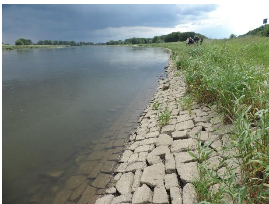
Foto 1: Blick auf Uferbefestigung. (Foto: STOWASSERPLAN)
