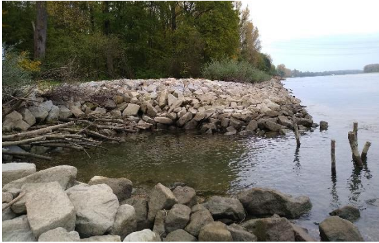
Foto 31: Einbau von Fischunterständen mit strömungsberuhigten Bereichen im Rahmen von Ufersanierungs- und Gestaltungsmaßnahmen. Der Einströmbereich wurde durch relativ eng stehende Weidensetzstangen markiert und von der Hauptströmung abgegrenzt. (Foto: STOWASSERPLAN)
