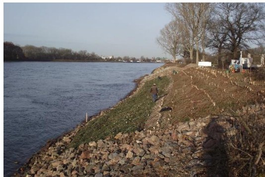
Foto 14: Kombination verschiedener ingenieurbiologischer Bauweisen (Foto: STOWASSERPLAN)
