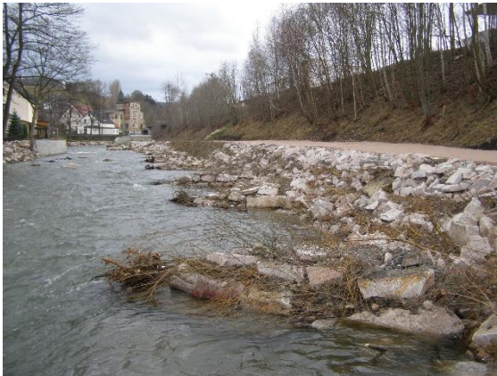
Foto 33: Diese Ufersicherung wurde mit begrünten Blockbuhnen kombiniert. (Foto: STOWASSERPLAN)
