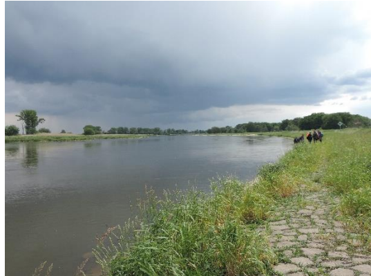
Foto 6: Blick auf Uferbefestigung (Foto: STOWASSERPLAN)
