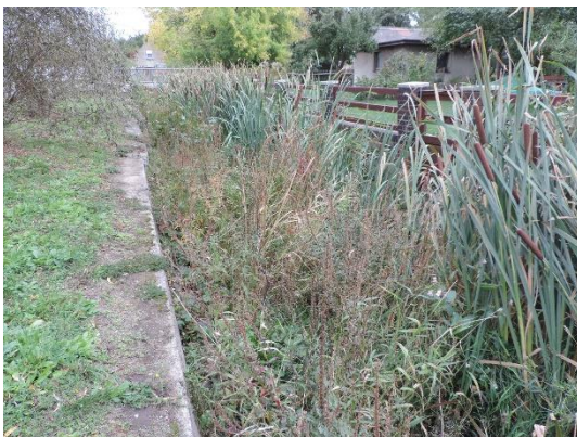
Foto 9: Ausgangszustand eines Gewässers mit beidseitigen Ufermauern (Foto: STOWASSERPLAN)
