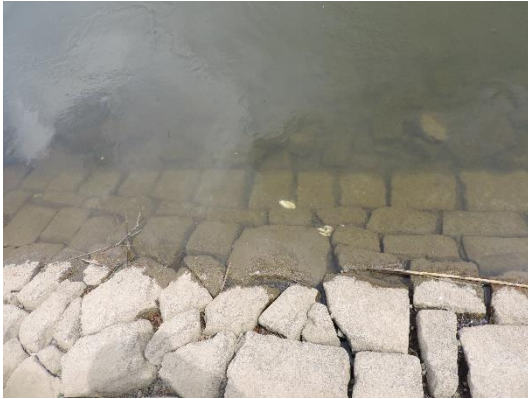
Foto 5: Blick auf Uferbefestigung (Foto: STOWASSERPLAN)
