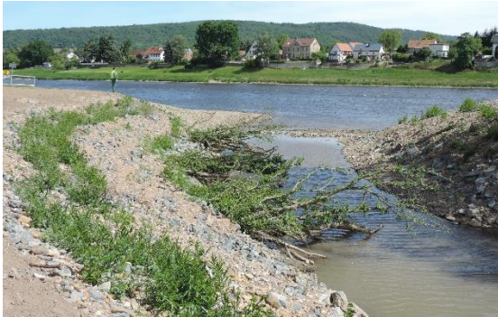
Foto 39: Die Ufersicherung des Seitenarmes wurde nur in Teilbereichen vorgenommen und vorrangig mit Bauweisen ausgeführt, die zur Strukturierung und Initiierung von Eigendynamik beitragen. Bei Niedrigwasser verhindert eine Sohlschwelle das Leerlaufen des Seitenarmes. (Foto: STOWASSERPLAN)
