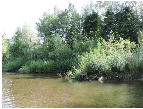
Foto 34: Die Buhnen drängen die Hauptströmung weg vom Ufer und zwischen den Buhnen entstehen ruhige Flachwasserbereiche. (Foto: STOWASSERPLAN)
