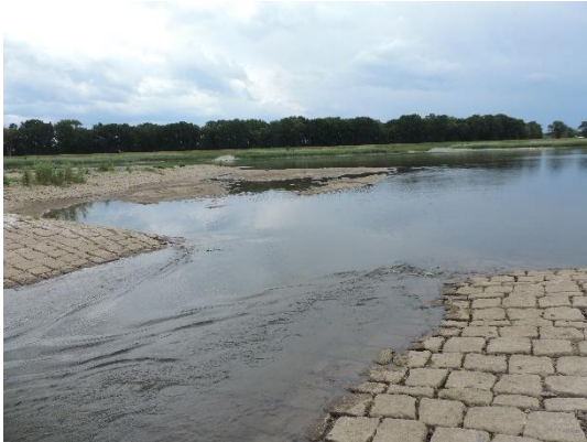
Foto 24: Einlaufbereich an einem aus Steinsatz errichteten Längswerk. (Foto: STOWASSERPLAN)
