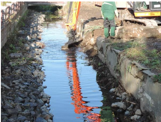
Foto 7: Gerade bei bereits verfallenden Ufermauern ist das partielle Aufbrechen des Verbaus und das Schaffen einer Aufweitung im Rahmen der Unterhaltung leicht umsetzbar. (Foto: STOWASSERPLAN)
