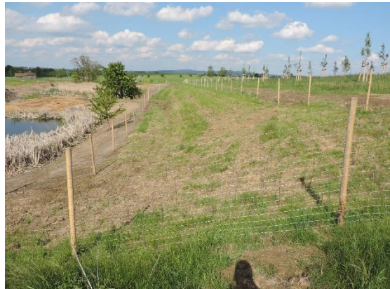
Foto 51: Durch ingenieurbiologische Bauweisen lassen sich standortgerechte Vegetationsbestände auf einfache Weise etablieren. Hier werden Steckhölzer zur Ansiedlung von Gehölzbeständen genutzt. (Foto: STOWASSERPLAN)
