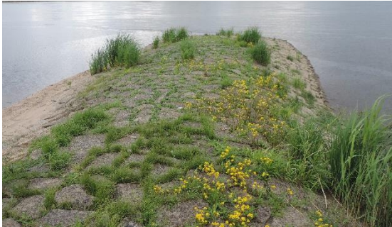
Foto 29: Die zur Sicherung der Schifffahrt eingebauten Buhnen ragen in die Strömung hinein, drängen diese vom Ufer weg und sorgen damit für die Freihaltung der Fahrrinne und gleichzeitig für Strömungsberuhigung in den Feldern zwischen den Buhnen. (Foto: STOWASSERPLAN)
