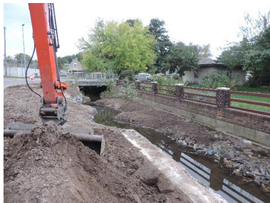
Foto 10: Zustand nach Fertigstellung des Teilrückbaus der Ufermauer und Böschungsprofilierung (Foto: STOWASSERPLAN)
