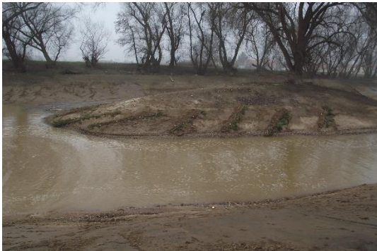
Foto 11: Lebendfaschinen sind eine lineare Ufersicherung. Sie können uferparallel oder geneigt eingebaut werden. (Foto: STOWASSERPLAN)
