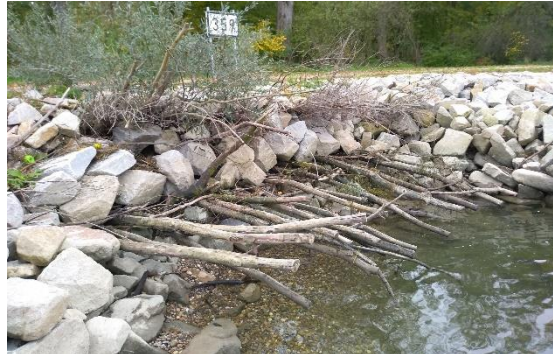
Foto 32: Die buchtenartigen Taschen in der Ufersicherung wurden mit lebendem Astwerk und Buschlagen begrünt. (Foto: STOWASSERPLAN)
