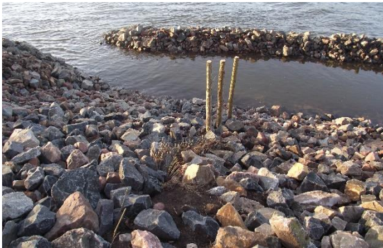
Foto 26: Das Längswerk aus Steinschüttung schafft unmittelbar einen strömungsberuhigten Bereich. Ergänzend dazu dienen Weidensetzstengen (Bildmitte) und Buschlagen (im Vordergrund des Bildes) dazu, durch die Vegetationsentwicklung eine weitere Strömungsberuhigung zu bewirken. (Foto: STOWASSERPLAN)
