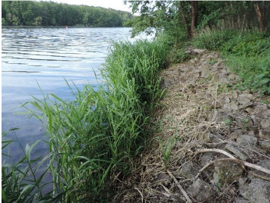
Foto 3: Gerade bei bereits verfallenden Ufermauern ist das partielle Aufbrechen des Verbaus und das Schaffen einer Aufweitung im Rahmen der Unterhaltung leicht umsetzbar. (Foto: STOWASSERPLAN)
