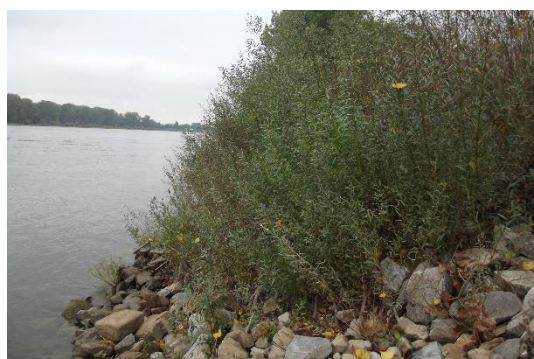
Foto 16: Nach wenigen Jahren hat sich aus den ingenieurbiologischen Bauweisen ein dichter Uferweidenbestand gebildet. (Foto: STOWASSERPLAN)
