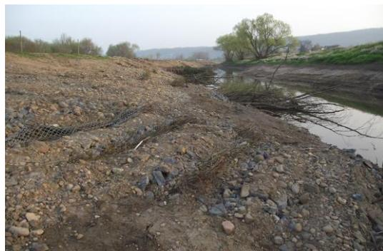
Foto 9: Zur Ufersicherung und Uferstrukturierung können ingenieurbio-logische Bauweisen zum Einsatz kommen. (Foto: STOWASSERPLAN)
