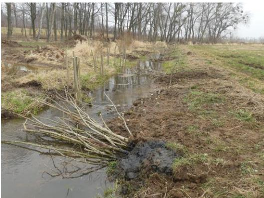
Foto 12: Lebender Abweiser, quer zur Fließrichtung eingebaute, austriebsfähige Äste, die sich zu einem dichten Weidengebüsch entwickeln. Die in den Stromstrich reichenden Äste bewirken Verwirbelungen mit Kolkbildungen sowie Strömungsberuhigungen im Randbereich. (Foto: STOWASSERPLAN)
