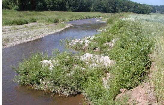
Foto 15: Begrünte Blockbuhne, Buhne aus gesetzten und geschütteten Lagen Wasserbausteinen mit einer Begrünung aus Buschlagen. Steinbuhnen bewirken auf Grund ihrer Massivität deutliche Veränderungen in der Strömung. Je nach Ausrichtung der Buhne (inklinant oder deklinant) werden Erosionen am Ufer und Kolkbildungen in der Gewässersohle ausgelöst. (Foto: STOWASSERPLAN)
