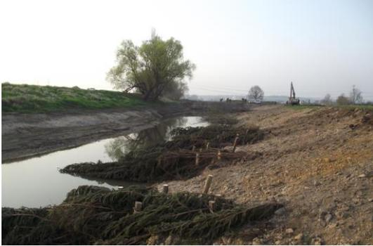
Foto 14: Raubaum, ganze Kronen oder Kronenteile von Laub- oder Nadelgehölzen, die mit der Krone flussabwärts orientiert und in die Fließrichtung geneigt am Ufer befestigt werden. Die Bauweise drückt die Strömung vom Ufer weg und provoziert Erosionen am gegenüberliegenden Ufer. Im Strömungsschatten des Raubaumes bilden sich Flachwasserbereiche und Anlandungen. (Foto: STOWASSERPLAN)
