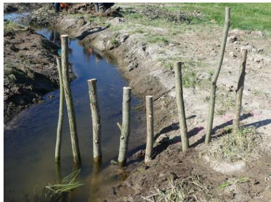
Foto 13: Rechenbuhne, Holzpfähle oder Weidensetzstangen werden als Reihe vom Ufer her bis in das Gewässer reichend quer zur Fließrichtung eingebaut. Derartige seitlich eingebaute Buhnen tragen zur Strömungsberuhigung in den Buhnenfeldern bei. Zwischen den Buhnen bilden sich Anlandungen. (Foto: STOWASSERPLAN)
