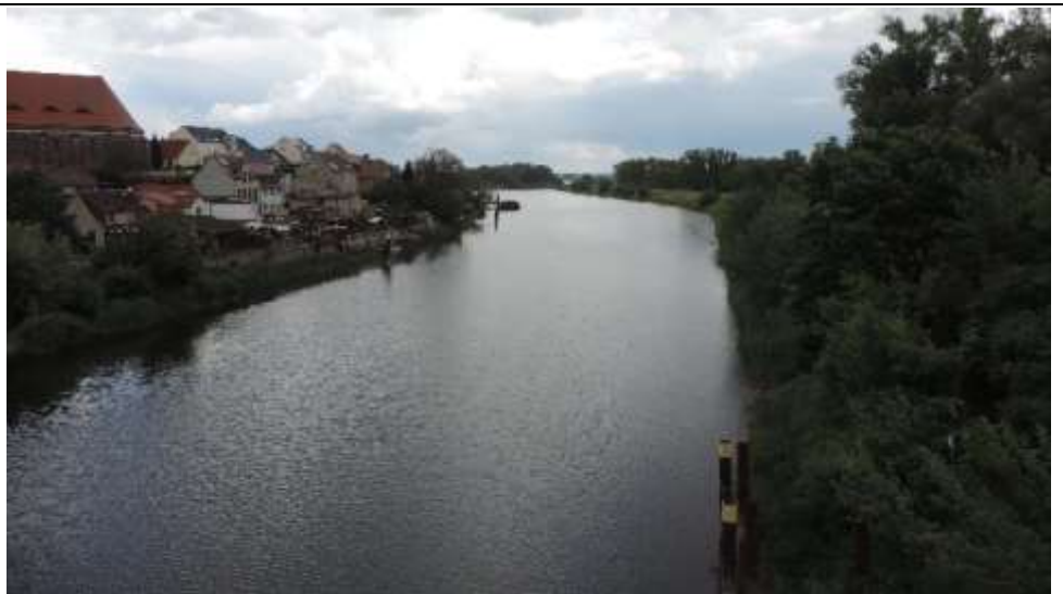
Abbildung 4: Oder-Spree-Kanal, Blick von Neuer Brück in Fließrichtung
