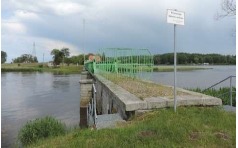
Abbildung 23: Blick auf Wehranlage Widuchowa (Marienhofer Wehr)
