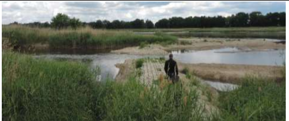
Abbildung 7: Einlauf Parallelwerk bei Reitwein
