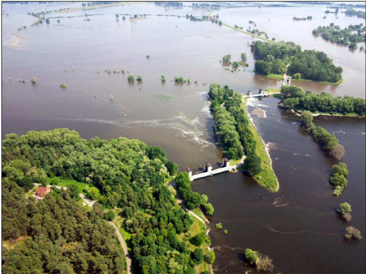
Abbildung 20: Mit der Wehranlage Quitzöbel an der Landesgrenze zwischen Sachsen-Anhalt und Brandenburg steuert der Landesbetrieb für Hochwasserschutz und Wasserwirtschaft Sachsen-Anhalt die Flutung der Havelpolder. (Quelle: Flussgebietsgemeinschaft Elbe 2013)
