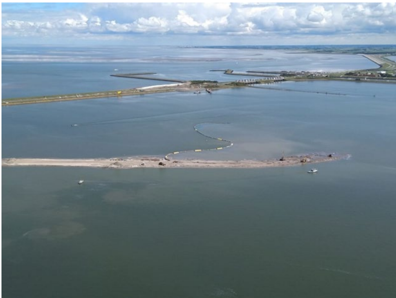
Abbildung 24: Bau des Fischwanderflusses, Juli 2020 © Rijkswaterstaat
