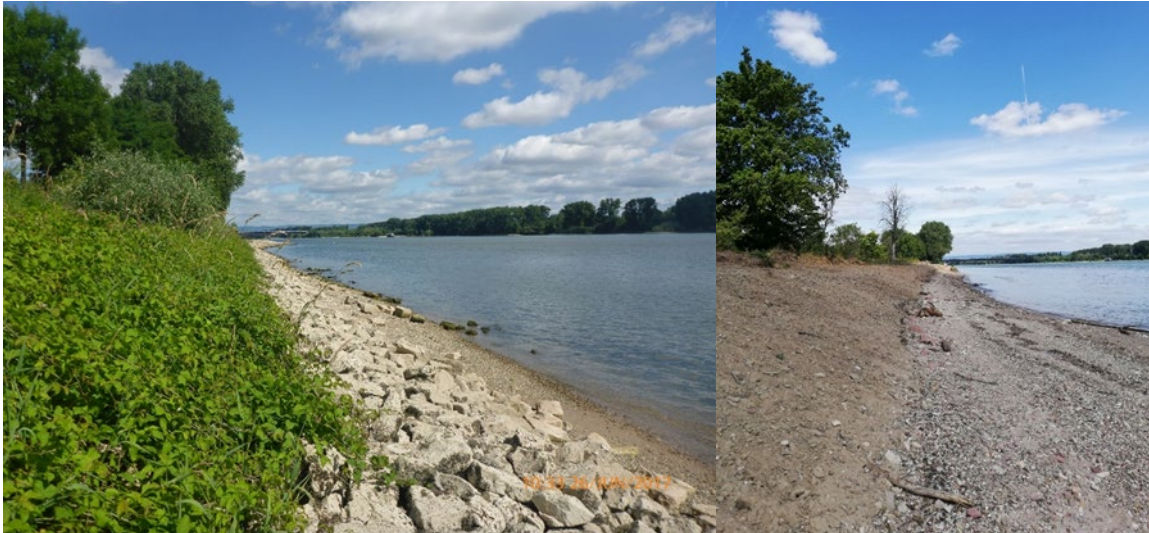
Abbildung 29: Rheinufer Mainz-Laubenheim (Rheinland-Pfalz) vor (links) und nach (rechts) der Strukturverbesserung – von harter Verbauung zum Flachufer (Fotos: Dorothea Gintz, BfG; Corinna Krempel, BfG).
