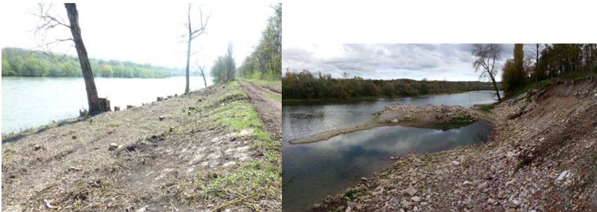
Abbildung 30: Linkes Ufer des Alt-/Restrheins (Frankreich) zwischen Basel und Breisach vor (links) und nach (rechts) der Maßnahme (Fotos: L. Schmitt, Laboratoire Image Ville Environnement, Université de Strasbourg, CNRS)
