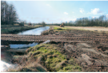
Baubeginn Blick stromab (Fotos: LKN)
