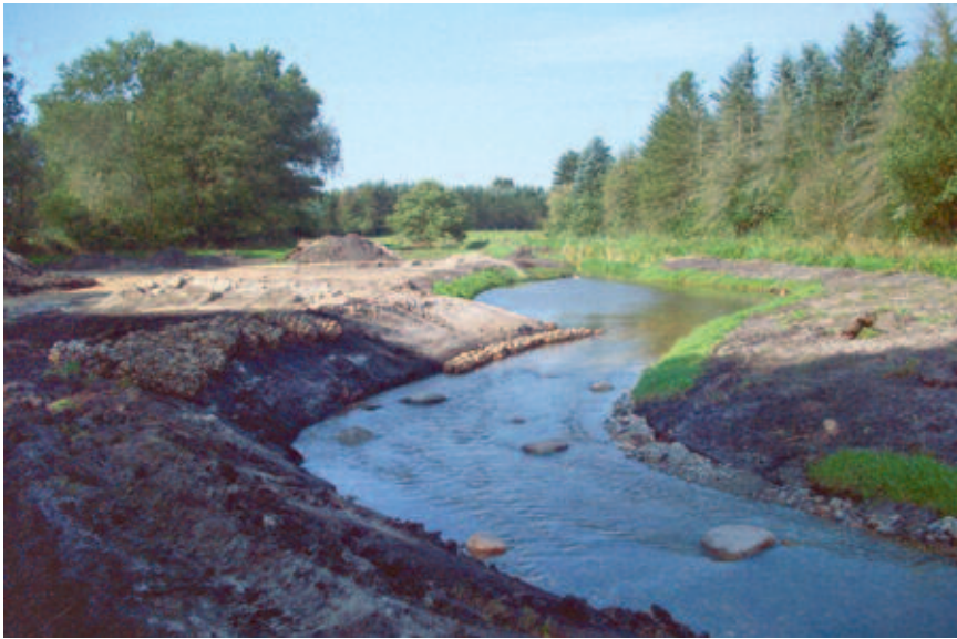
Nach Umsetzung: Sandfang Radesforder Au ca. Station 0+850, (Fotos: LKN)
