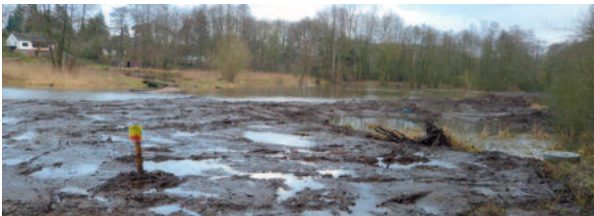
Im Bau (Fotos: LKN)
