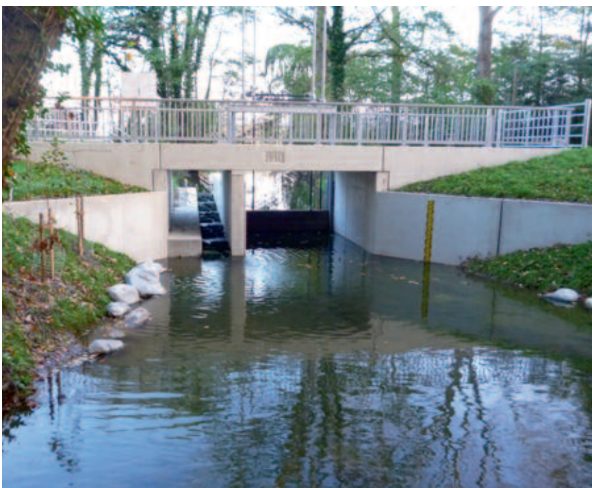
Zustand nachher, Borstenfischpass + Doppelschützanlage
