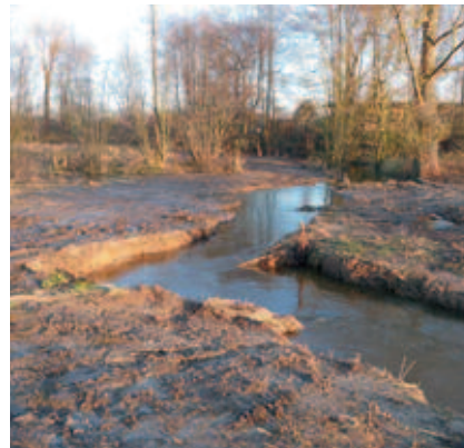
Bauphase, Kolk in „90°-Kurve“
