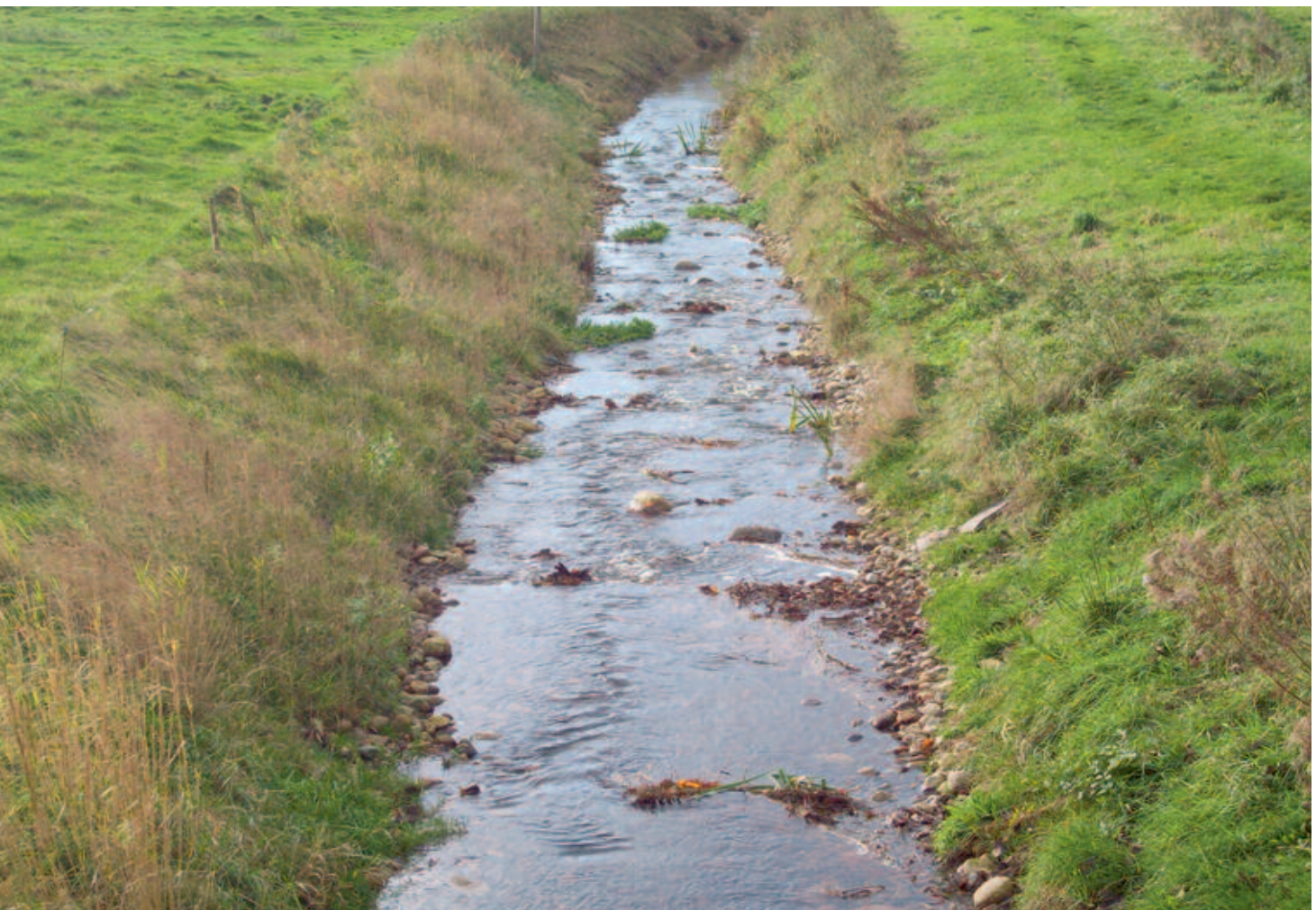
Sohlgleite im Mühlenbach (siehe Steckbrief Nr. 27)
