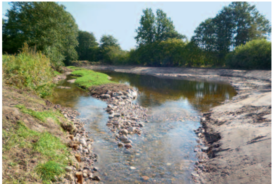
Im Bau: Sandfang (Fotos: LKN)
