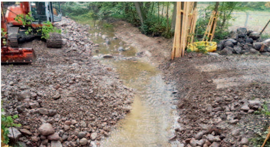
Im Bau (Foto: LKN, I. Radig)
