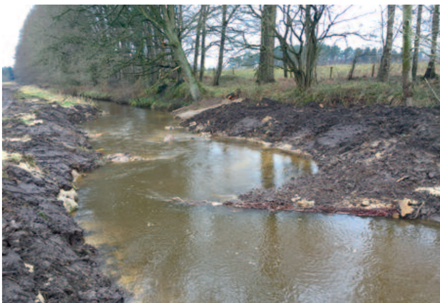
Wiemersdorfer Au Bauphase; Furt-Kolk-Sequenz (Fotos: LKN)
