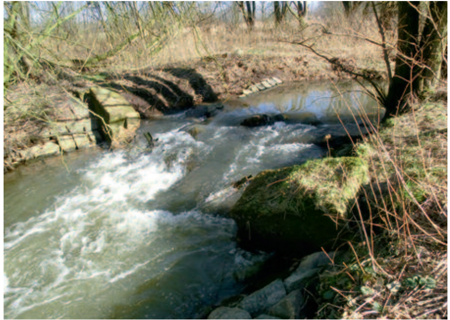
Sohlabsturz vor Umsetzung (Fotos: LKN)
