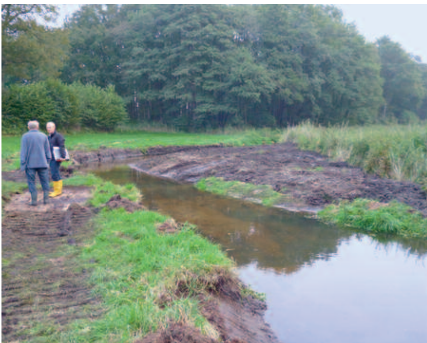
Nach Umsetzung: Sandfang Rothenmühlenau ca. Station 0+800
