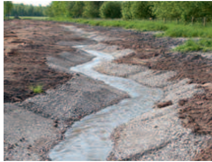
Kurz nach dem Bau (Fotos: LKN)
