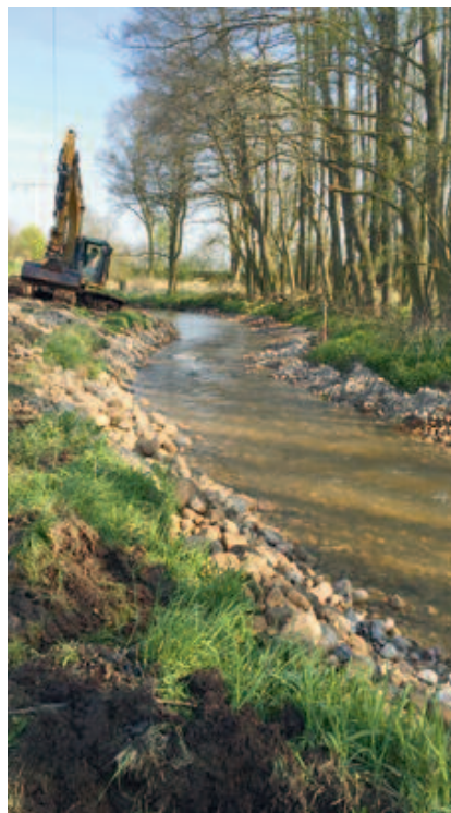
Im Bau, Blick stromab
