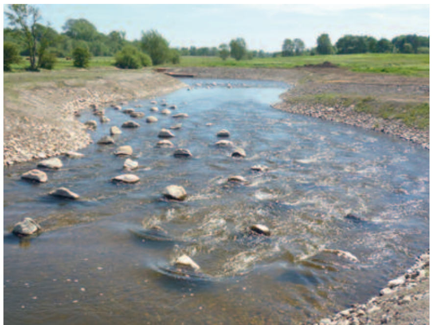
Übersichtsplan (Quelle: Ing.-Büro Däne- kamp und Partner ) unten: Umgehungsgerinne mit Sohlgleite
