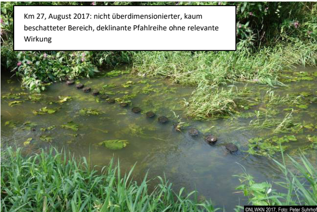
Km 27.7, August 2017 überdimensionierter, beschatteter Bereich deklinante Pfahlreihe ohne relevante Wirkung
