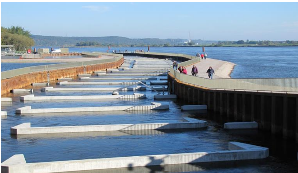
Abbildung 5-3: Wehr Geesthacht, Strom-km 586, Blick auf die Fischwechseinrichtung am Nordufer (Quelle: Th. Gaumert)
