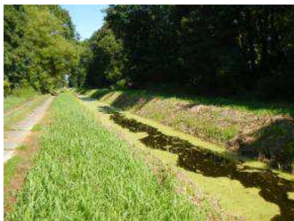
Abbildung 5-74: Abschnitt P01 (Unterlauf)
