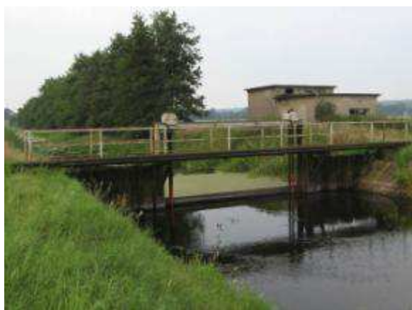
Abbildung 5-116: Abschnitt P01 mit Stauwehr
