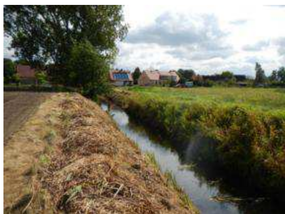
Abbildung 2-29: Buchtgraben nach erfolgter einseitiger Böschungsmahd und Sohlkrautung
