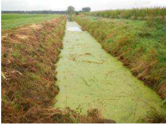
Abbildung 5-88: Abschnitt P01 (Unterlauf)
