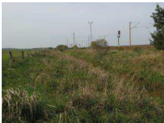
Abbildung 5-23: Unterlauf Siegggraben Brieselang mit Bahnkörper
