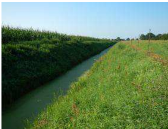
Abbildung 5-62: Abschnitt P01 (Unterlauf)
