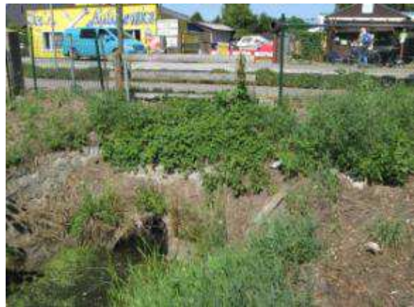
Abbildung 5-39: Abschnitt P06 mit Rohrleitung
