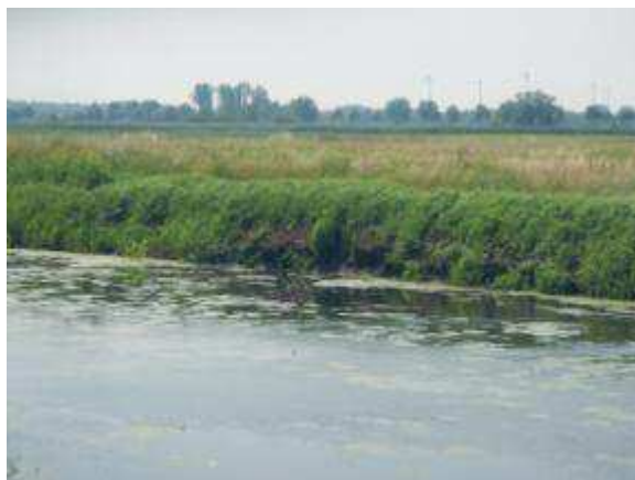
Abbildung 5-130: GHHK bei Station 46+707
