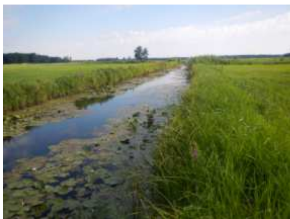
Abbildung 5-102: Abschnitt P01 (Unterlauf)
