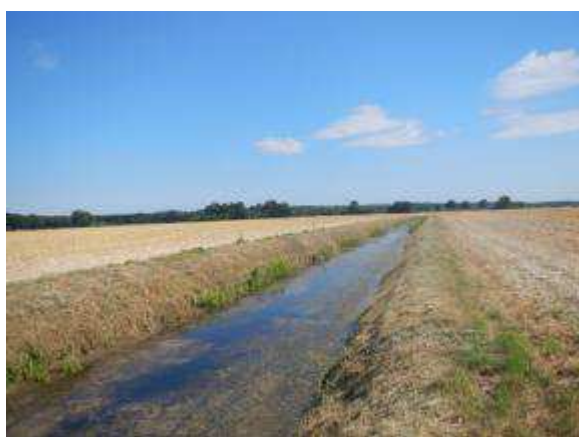
Abbildung 5-106: Abschnitt P01 (Unterlauf)
