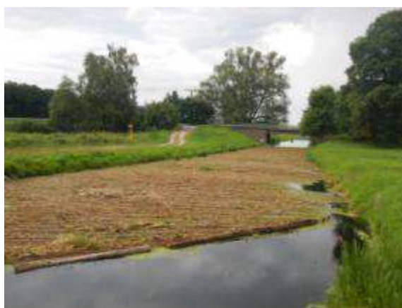
Abbildung 2-30: Krautbalken mit Mähgut im GHK am Wehr Rhinsmühlen
