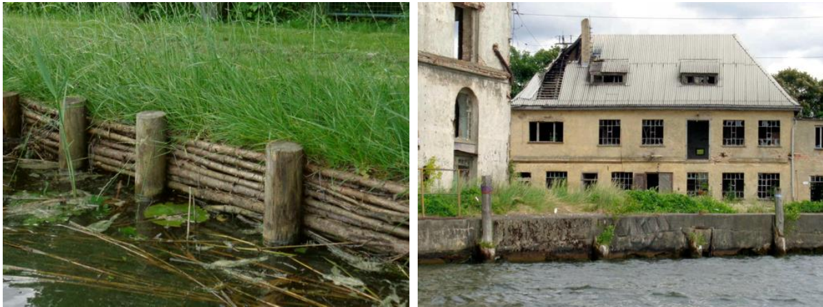
Abbildung 13: Uferverbau. Links - Einfache Uferbefestigungen aus Palisaden mit Flechthölzern (Objekttyp 1_2) am Kleinen Wentowsee (Foto W. Ostendorf, 17.06.2014). Rechts – Betonierte Ufermauern (Objekttyp 3_6) an einem ehemaligen Verladekai der Behrnschen Mühle am Röblinsee (Foto W. Ostendorf, 13.06.2014).
