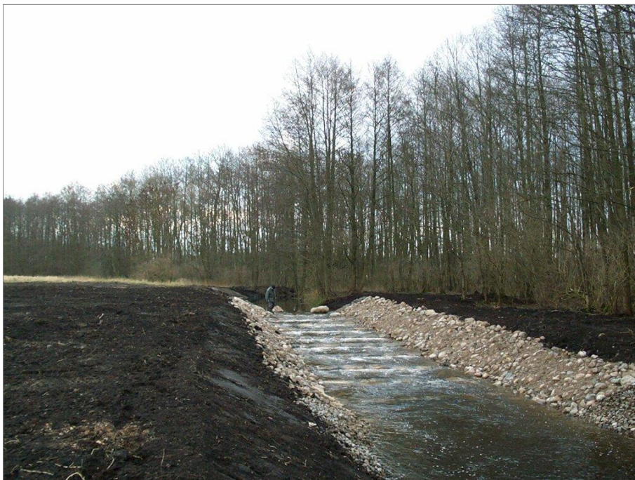
Abbildung 4-5: Fischaufstiegsanlage an der Göwe als raue Rampe (Foto: A. Küchler)
