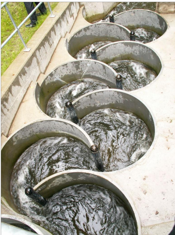
Abbildung 4-7: Mäanderfischpass am selben Standort in der Mildnitz (Foto: A. Küchler)
