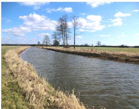
Abbildung 6-13: Löcknitz-Abschnitt 1 km oberhalb des Wehres Jagel
