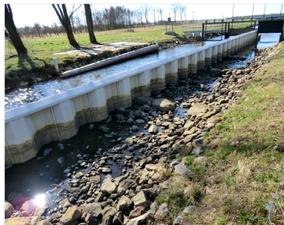
Abbildung 6-14: Wehr Jagel an der Löcknitz mit trocken gefallener Fischeaufstiegsanlage (19.03.2012)
