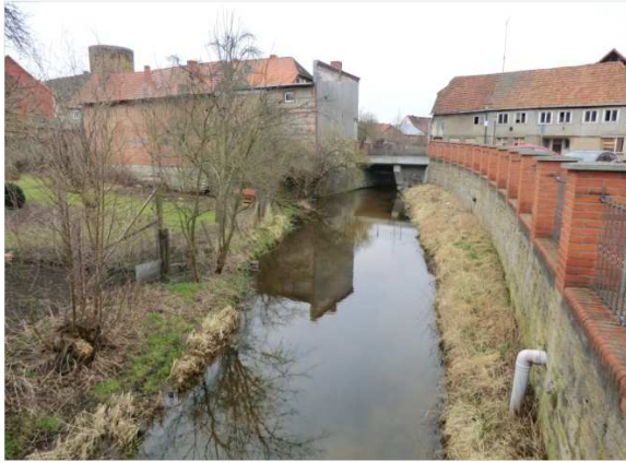
Abbildung 5-41: Rudower Seekanal (593278_1056) in der Stadt Lenzen
