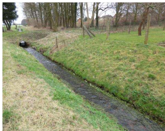
Abbildung 6-28: oberer Bereich des P02 am Postliner Graben
