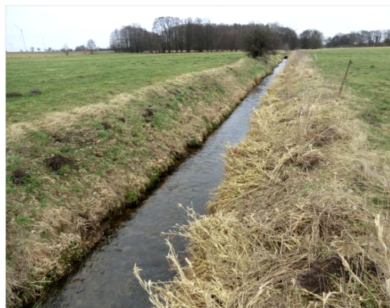
Abbildung 6-40: Bereich Premsliner Graben unterhalb des Waldes bei Glövizin
