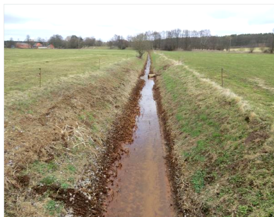
Abbildung 6-36: starke Verockerungen am Achterberger Graben vorhanden
