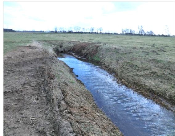
Abbildung 6-22: Beginn der Verrohrung am Kleester Grenzgraben
