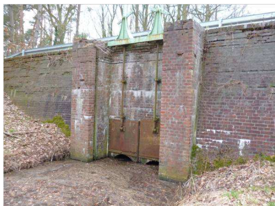
Abbildung 2-32: Absperrbauwerk (oberhalb) bei Cumlosen (21.03.2012)
