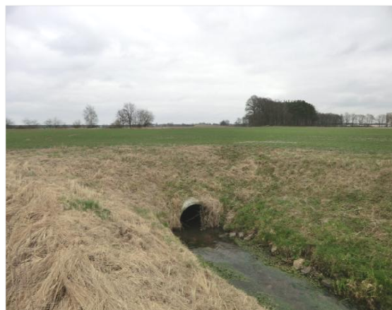
Abbildung 6-26: Beginn der unteren Verrohrung am Postliner Graben
