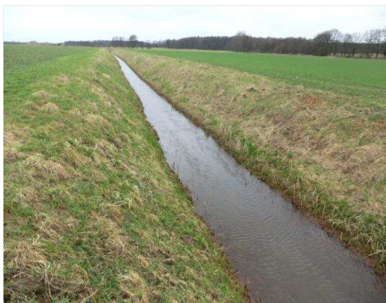
Abbildung 6-49: Stark eingetiefter Boberower Graben
