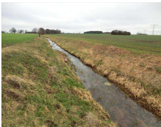
Abbildung 6-35: sehr stark eingetiefter Abschnitt am Achterberger Graben
