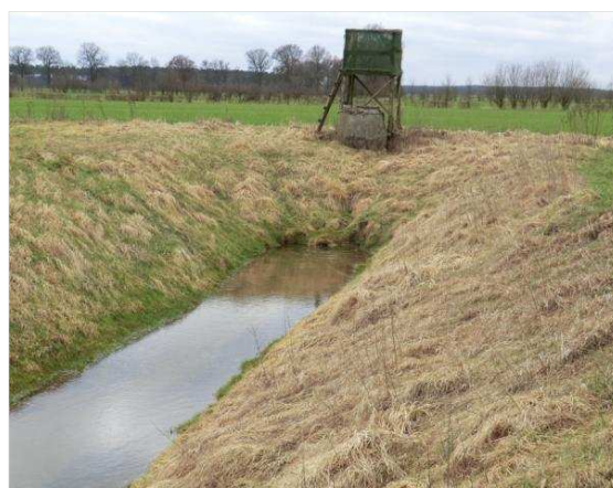
Abbildung 6-52: Beginn der Verrohrung am Mittelfeldgraben
