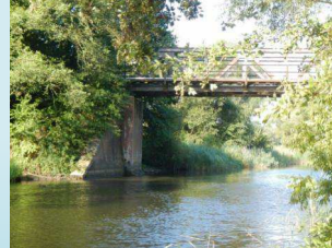
ehemalige Eisenbahnbrücke (km 1,4)
