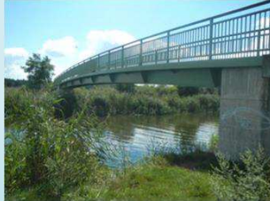
Rad- und Fußgängerbrücke (km 5,8)
