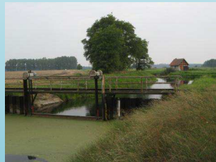
Einmündung in GHKK
