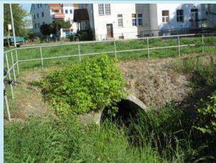
Rohrleitung Bahnhof Finkenkrug (km 6,1, BW07)
