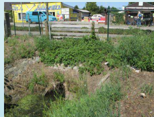
Rohrleitung Bahnhofstraße (km 10,1, BW15)
