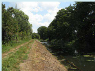
Ufersicherung Sommer 2014 (km 1,0)
