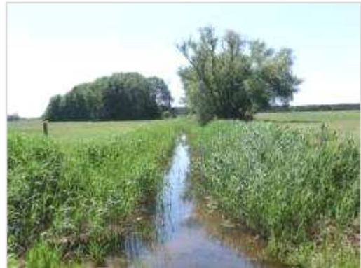
Abbildung 6-28: Bereich unterhalb des ersten Staubauwerkes bei Stat. 1+800
