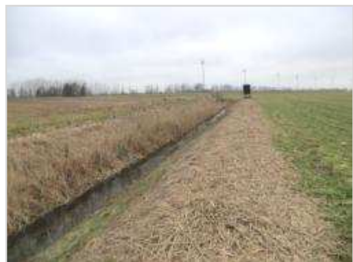
Abbildung 6-29: P02 bei Stat. 7+400, oberhalb der Verrohrung
