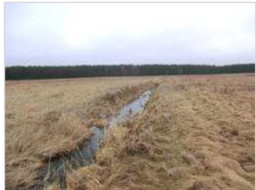
Abbildung 6-10: ausgebauter P05 nördlich von Pfalzheim
