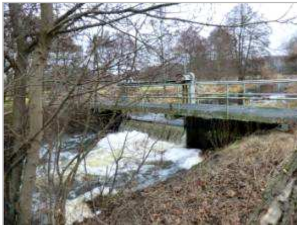
Abbildung 5-43: Wehr Paalzow in der Temnitz (5886_197)
