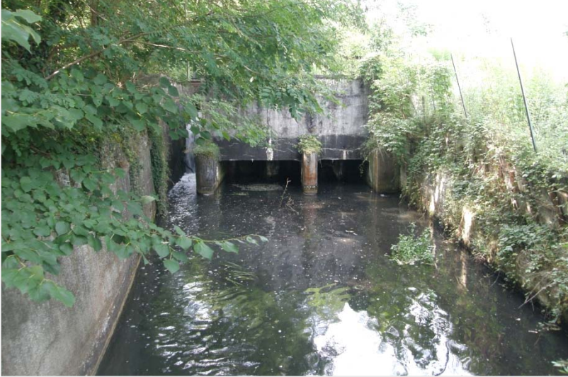
Wehr Elsthal (Nuthe) in Luckenwalde – 2011 Umbau in eine Sohlgleite
