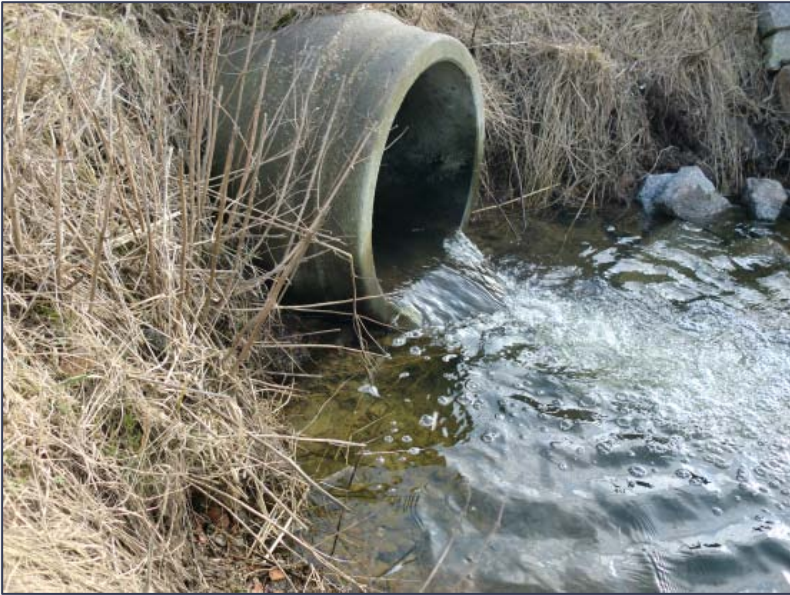
Durchlass ohne Substrat, mit Absturz
