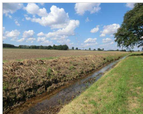
Abbildung 6-32: Nutzungen bis an die Böschungskante am Postliner Graben
