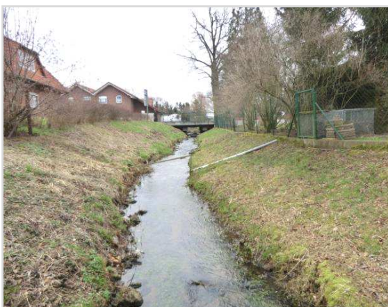
Abbildung 6-27: Postliner Graben Ortsbereich Postlin unterhalb der Straßenbrücke der L131
