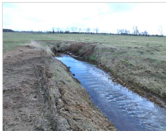
Abbildung 6-22: Beginn der Verrohrung am Kleester Grenzgraben
