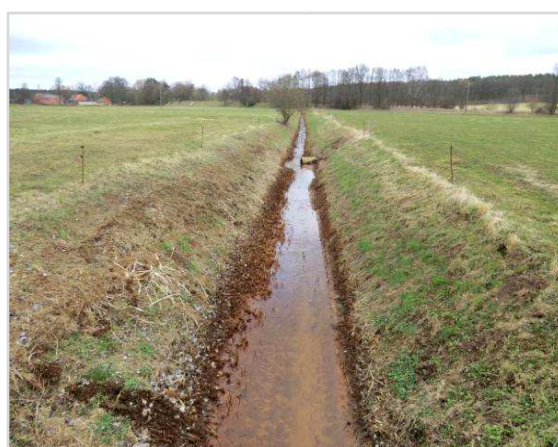
Abbildung 6-36: starke Verockerungen am Achterberger Graben vorhanden
