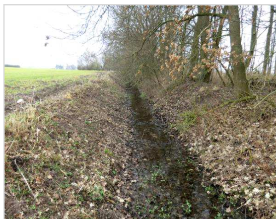
Abbildung 6-46: Oberer Bereich (ca. 200 m) am Nebeliner Graben
