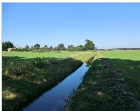
Abbildung 6-47: Strukturloser Boberower Graben
