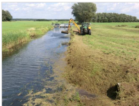
Abbildung 2-28: Böschungsmahd mittels Bagger mit Mähkorb an der Löcknitz uh. Wehr Jagel (Stat. 38+408)
