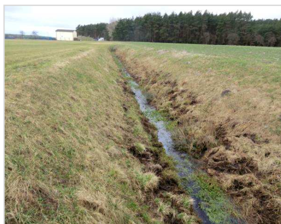
Abbildung 6-34: auf Höhe WW Seetz Beginn der dritten Verrohrung am Seetzer Graben
