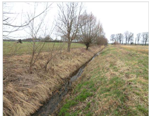
Abbildung 6-42: Bereich unterhalb der Verrohrung am Premsliner Graben
