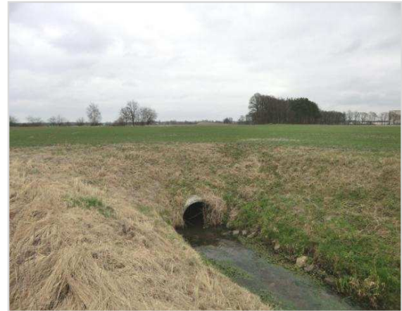
Abbildung 6-26: Beginn der unteren Verrohrung am Postliner Graben
