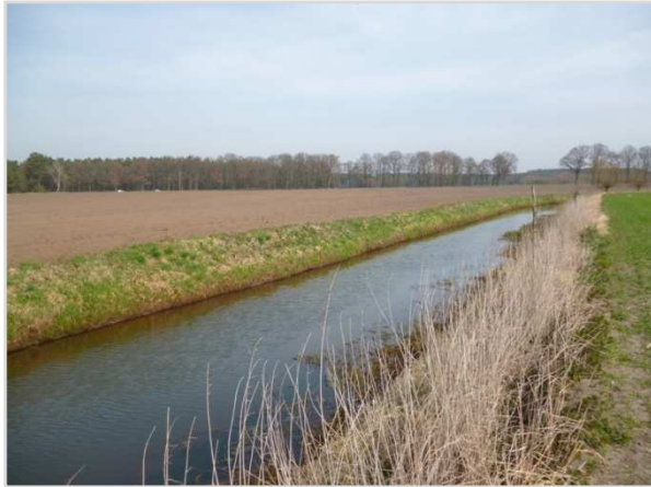
Abbildung 5-39: Unterlauf des Schmaldiemens (59326_540)
