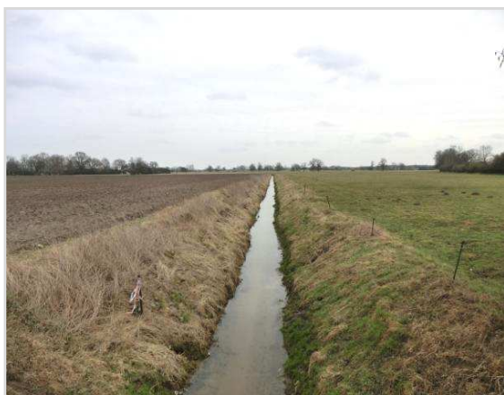
Abbildung 6-45: Nutzungen bis an die Böschungskante am Nebeliner Graben
