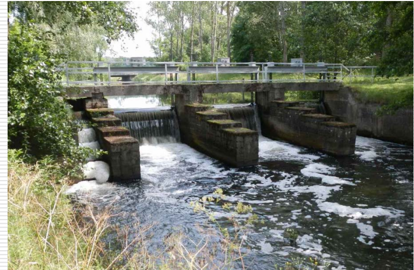
Wehr Tramnitz mit alter Fischtreppe
