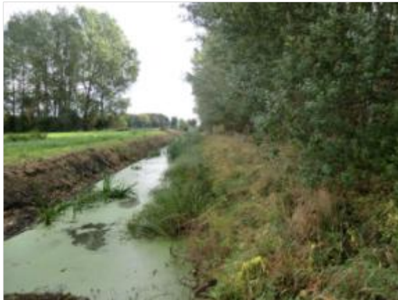
Abbildung 2-27: Rhingraben nach erfolgter einseitiger Böschungsmahd
