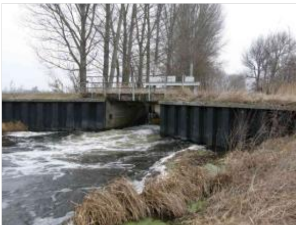
Abbildung 2-22: Wehr Nackel (Temnitz)
