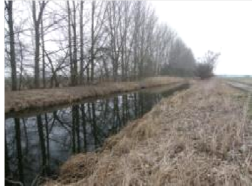
Abbildung 6-4: P01 kurz oberhalb des Wehres Nackel
