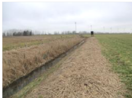
Abbildung 6-29: P02 bei Stat. 7+400, oberhalb der Verrohrung
