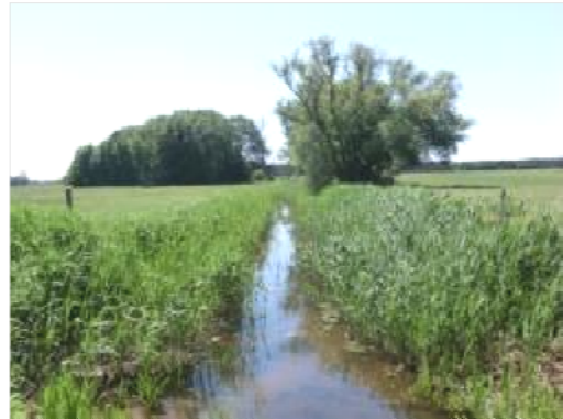
Abbildung 6-28: Bereich unterhalb des ersten Staubauwerkes bei Stat. 1+800
