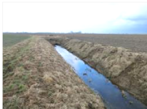
Abbildung 6-27: Abschnitt oberhalb der A24
