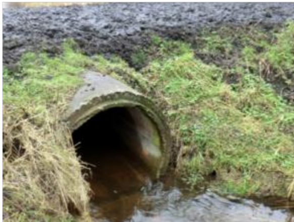
Abbildung 5-40: Links Rohrdurchlass ohne Substrat auf der Sohle, rechts unüberwindbarer Sohlprung
