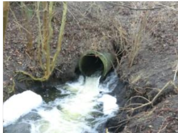
Abbildung 5-40: Links Rohrdurchlass ohne Substrat auf der Sohle, rechts unüberwindbarer Sohlprung
