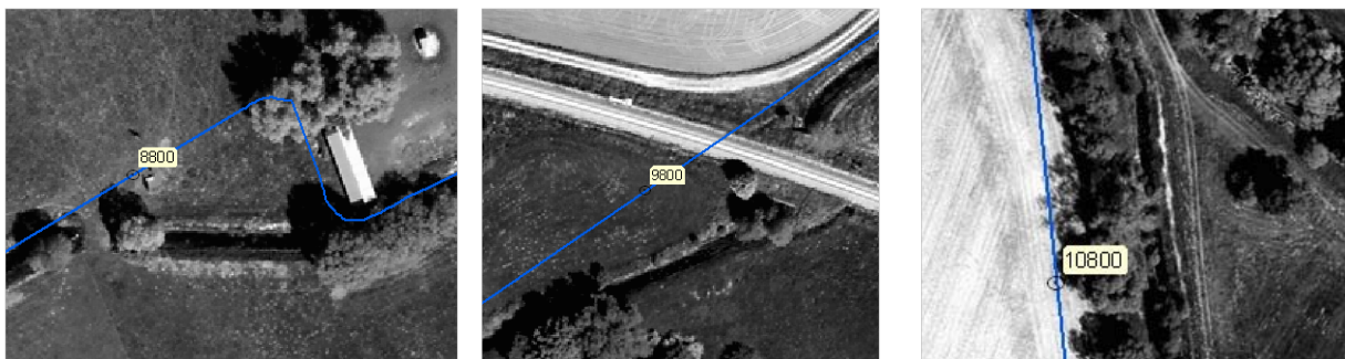
Abbildung 5-53: Routenabweichungen, blaue Linie – ausgewiesener Routenverlauf
