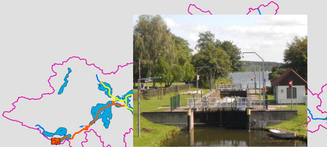
Schleuse Himmelfort Wasserspiegeldifferenz: 1,2 m
