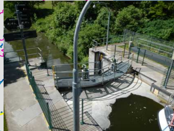
Schleuse Templin Wasserspiegeldifferenz: 4,3 m
