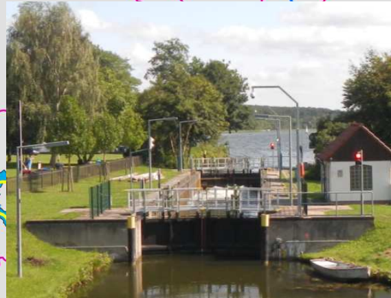
Schleuse Himmelfort Wasserspiegeldifferenz: 1,2 m
