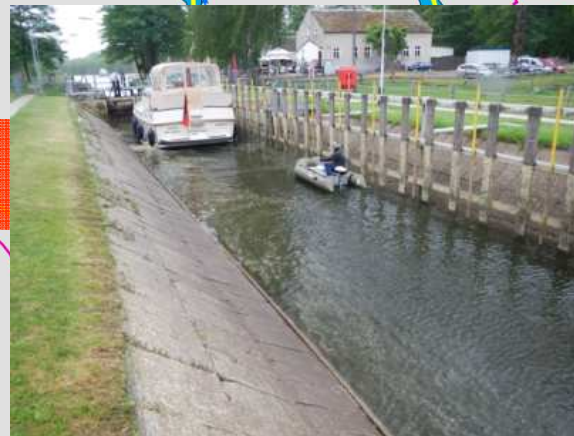
Schleuse Templin Wasserspiegeldifferenz: 4,3 m
