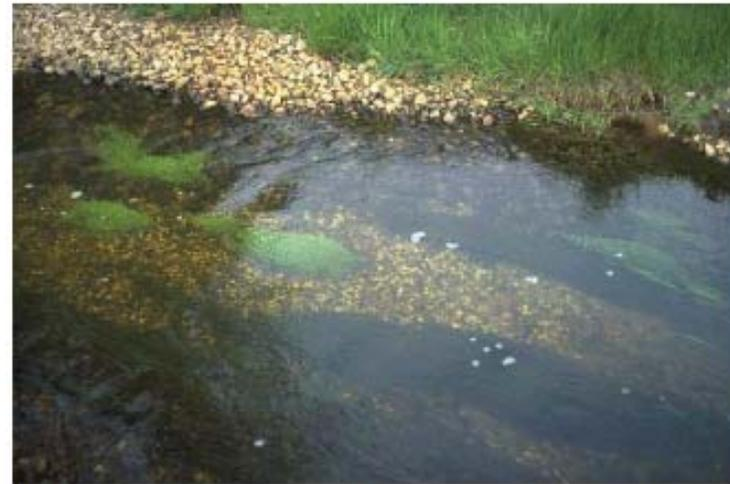
**Bild 94:** Einbringen von Kies in übermäßig versandete Tieflandbäche zur Entwicklung von Laichhabitaten (Foto: AKN, L. TERT)
