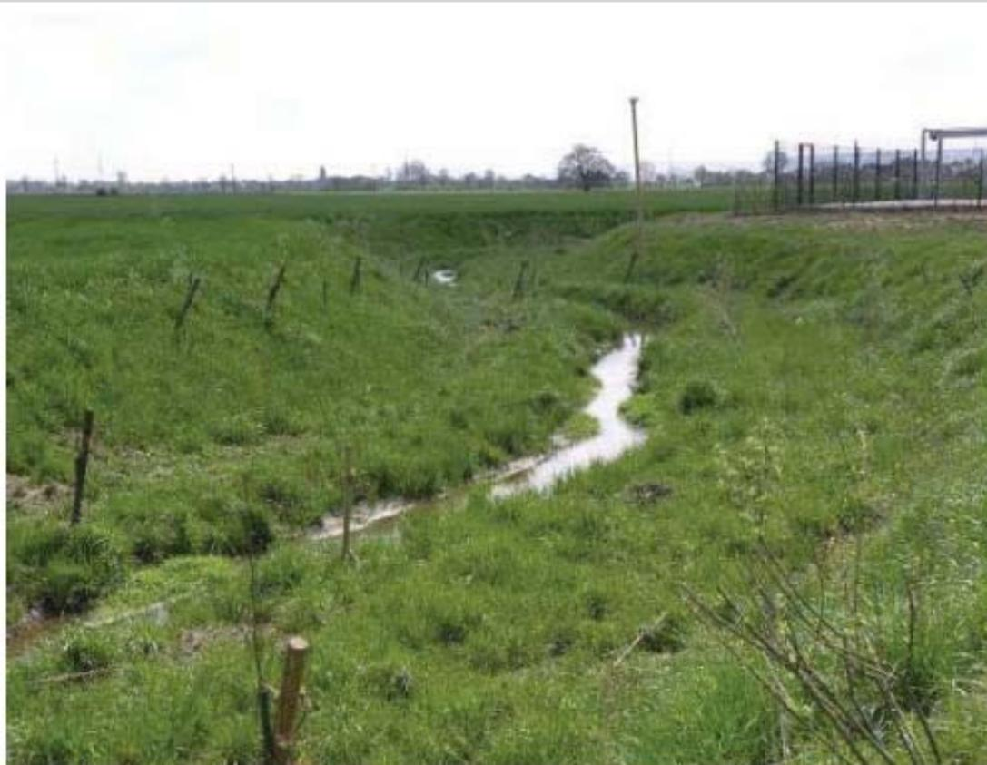
**Bild 144: Bauliche Anlage einer Sekundäraue innerhalb intensiv genutzter landwirtschaftlicher Flächen durch Profilaufweitung auf Mittelwasserniveau (Foto: U. KOENZEN)**
