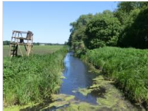
Abbildung 6-26: P02, östlich der A24, bei Stat. 14+900
