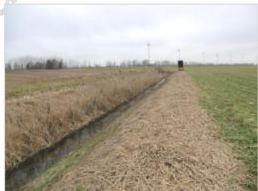
Abbildung 6-29: P02 bei Stat. 7+400, oberhalb der Verrohrung
