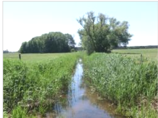
Abbildung 6-28: Bereich unterhalb des ersten Staubauwerkes bei Stat. 1+800
