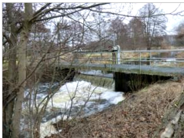
Abbildung 5-43: Wehr Paalzow in der Temnitz (5886_197)
