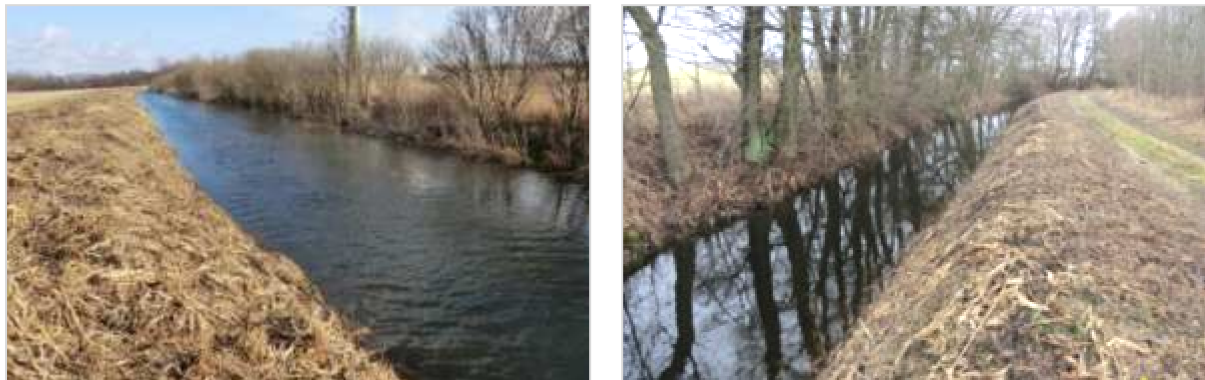
Abbildung 6-12: Links Planungsabschnitt bei Stat. 4+400, kurz oberhalb der ehemaligen Eisenbahnstrecke; rechts bei Stat. 12+100, auf Höhe Siegmundshof
