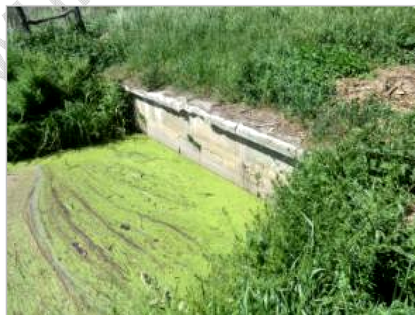
Abbildung 5-44: überstauter Plattendurchlass im Rhingraben
