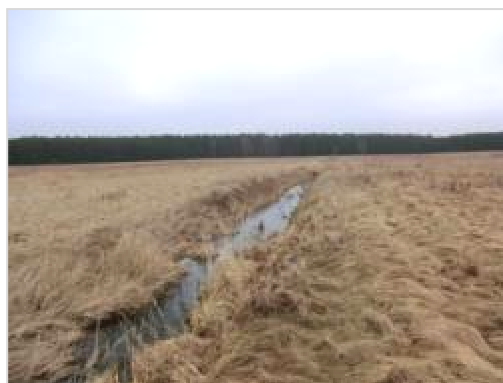
Abbildung 6-10: ausgebauter P05 nördlich von Pfalzheim
