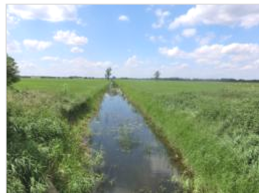
Abbildung 6-33: Bereich bei Stat. 16+700
