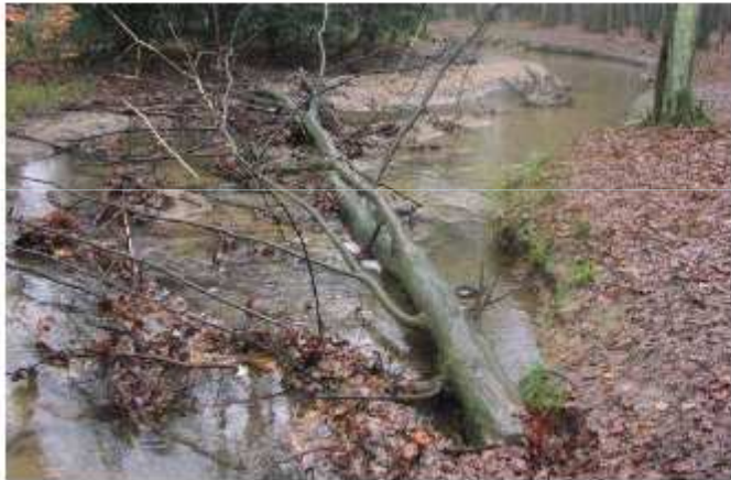
Bild 93: Einbringen von Totholz in einem sandgeprägten Bach des Tieflandes – im Hintergrund das Regelprofil ohne Totholz. Die Gehölze wurden durch den örtlichen Forstbetrieb eingebracht. Ohne Totholz weist das Gewässer eine einheitliche sandgeprägte Sohle mit starken Rippelmarken auf (Foto: U. KOENZEN)
