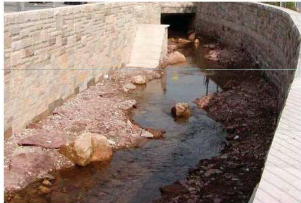
Bild 96: Auch unter restriktiven Bedingungen ist es möglich, Ersatzstrukturen in einem urbanen Umfeld zu schaffen (Foto: UIH)
