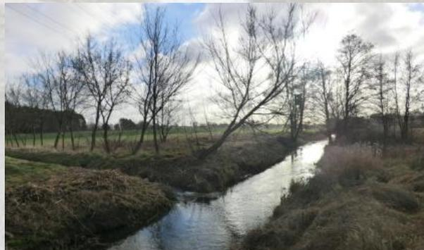
geradlinig und tief eingeschnittenes Trapezprofil im Unterlauf
