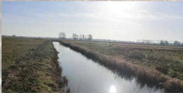
geradliniger bis gestreckter Lauf im ausgebauten Trapezprofil (im Sommer stark beschilft)
