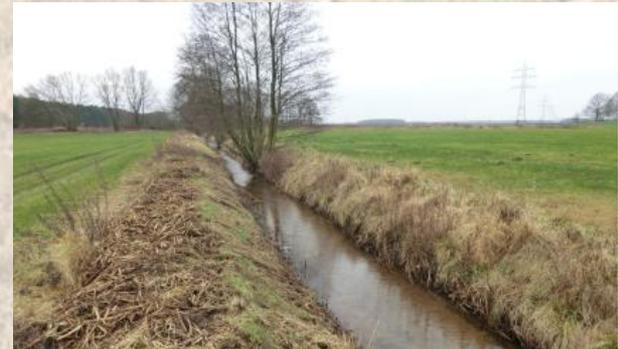
geradlinig ausgebautes Trapezprofil ohne besondere Sohl- und Uferstrukturen
