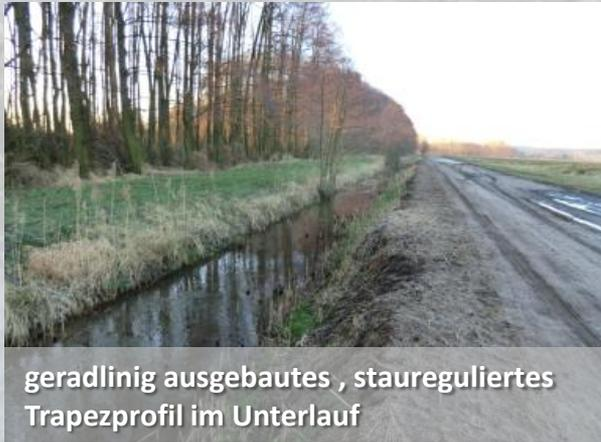
geradlinig ausgebautes , staureguliertes Trapezprofil im Unterlauf
