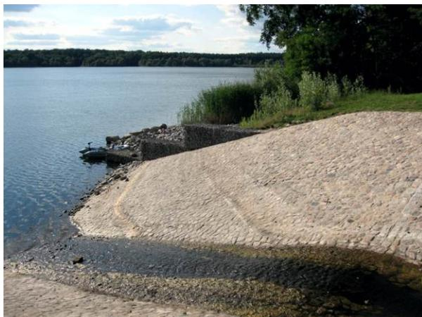
Abbildung 43: Zulaufbauwerk des Dosse-Zuleitungskanals in den Obersee (Foto: W. Ostendorf, 12.08.2012)
