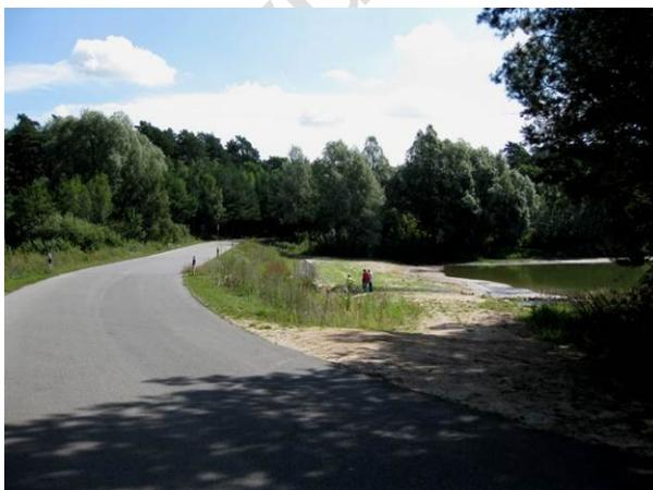
Abbildung 38: Damm des Mühlenteichs mit Fahrstraße aus Richtung Bork gesehen. Der Mühlenteich befindet sich am linken Bildrand, der Obersee am rechten Bildrand; zu sehen ist das Auslassbauwerk sowie Reste der Baustraße (Foto W. Ostendorf, 14.08.2012).
