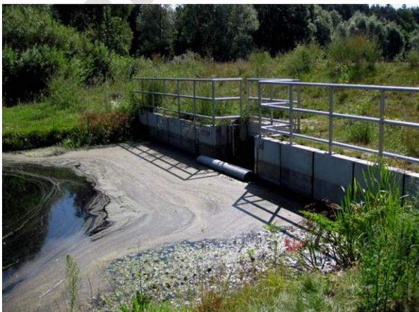
Abbildung 41: Auslassbauwerk des Mühlenteichs unter dem Verkehrsdamm Bork. Die dunkle Färbung des Betons kennzeichnet den Maximalwasserstand von 2011/12 (Foto W. Ostendorf, 14.08.2012)
