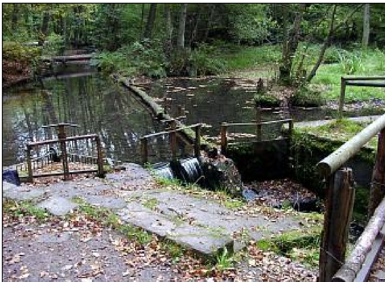
Wehr vor der Baumaßnahme
