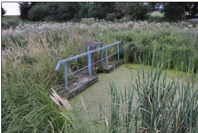
Abbildung 7: Genutzter Stau zur Wasserregulierung im Rahmen landwirtschaftlicher Nutzung unterhalb der „Quelle“ des künstlichen Oberlaufs des Schurkengrabens (Foto: F. Tugendheim, 12.08.2010)
