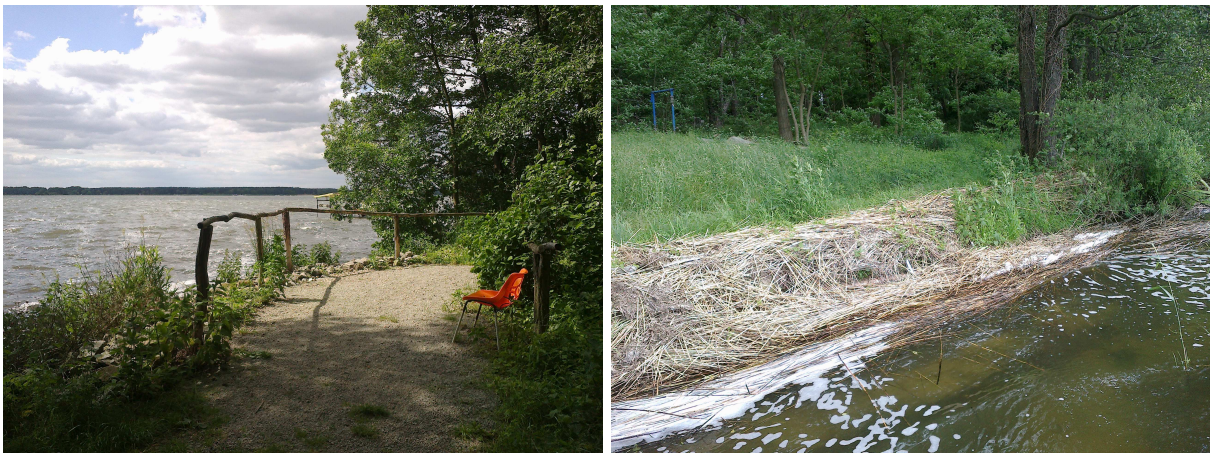
Abb. 34: Ufersicherung bei Speichrow vor Wellenschlag mit Steinschüttung (links) und „nacktes“ Ufer mit kleiner Abspülkante und angeschwemmtem Altschilf (rechts)
