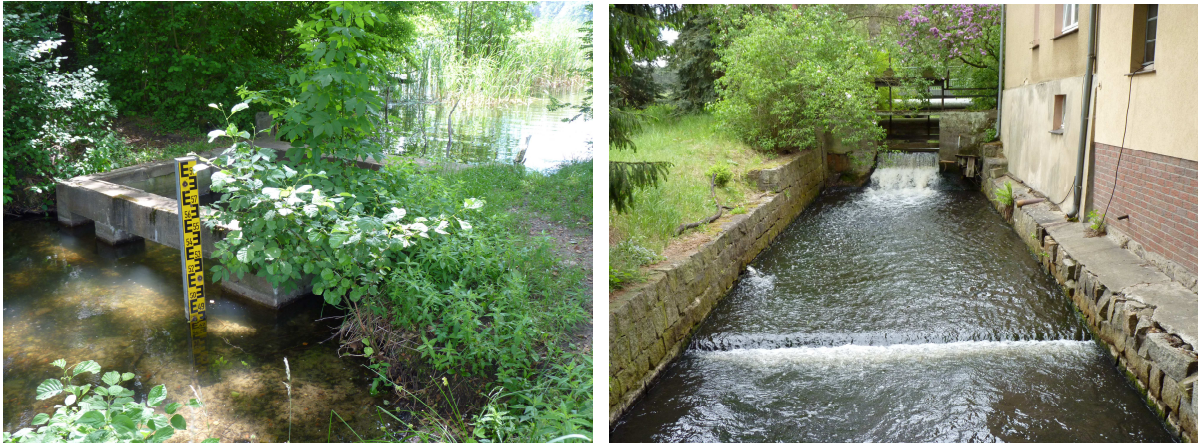
Abb. 49: Für das Abschlagsbauwerk am Großen Mochowsee (links) wurde eine Genehmigungsplanung erstellt. Die Umsetzung ist für 2016 geplant. Für das Staubauwerk der Resserer Mühle (rechts) wurde eine Vorplanung mit mehreren Varianten erstellt
