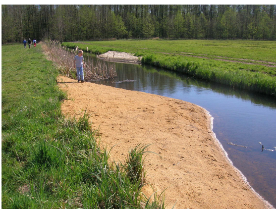
Abb. 43: Links: Im Jahr 2007 neu angelegte Sandbuhnen im Tuschatzgraben im Unterspreewald; Rechts: Substratsortierung im Blasdorfer Graben unterhalb eines Uferabbruchs
