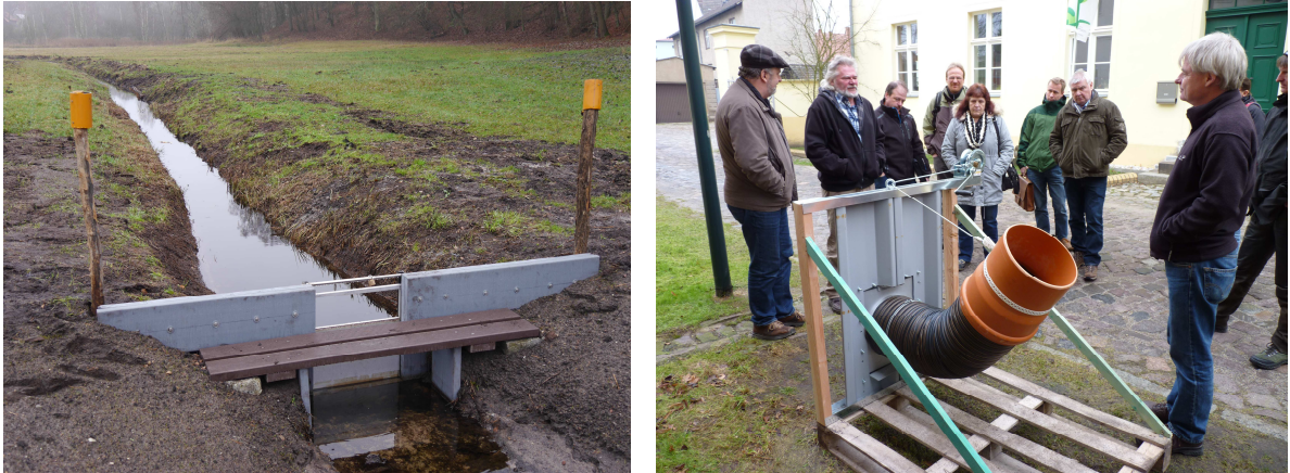
Abb. 39: Links: Moorgrabenstau in der Staakower Moorwiese kurz nach der Fertigstellung. Die Stauhöhe ist hier noch nicht erreicht. Rechts: stufenlos regulierbarer Stau des Büros AKUT, Berlin
