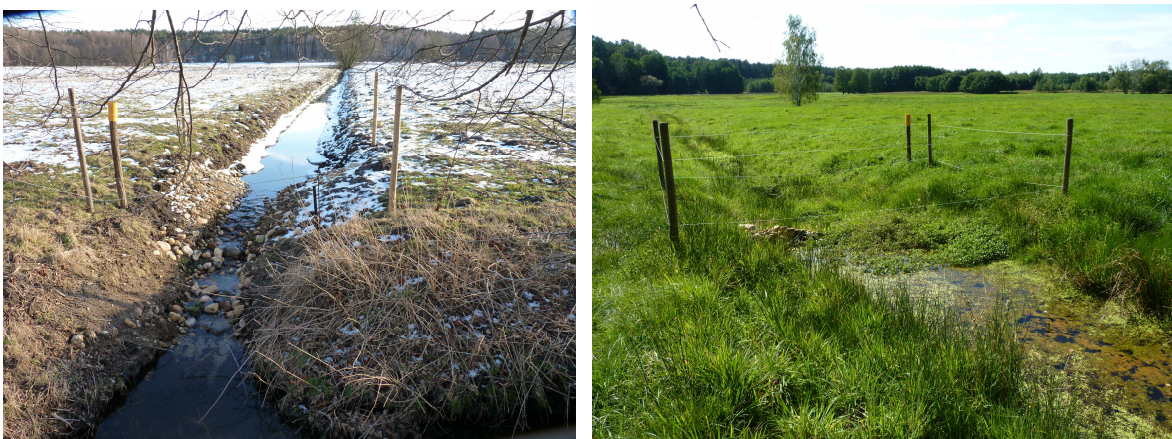
Abb. 40: Stützwällen im Blasdorfer Quellmoor, die im Rahmen einer LWH-Maßnahme durch den WBV „Mittlere Spree“ errichtet wurden. Rechts ist der Nährstoffrückhalt anhand der Algenentwicklung oberhalb der Schwelle erkennbar
