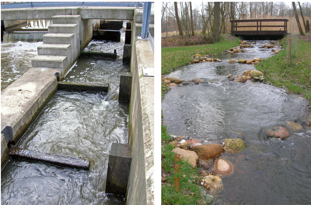
Abb. 48: Links: Vertical-Slot-Pass in der Neuen Spree in Burg / Oberspreewald; Rechts: naturnaher Rauherinne-Beckenpass am Schiwastrom im Unterspreewald
