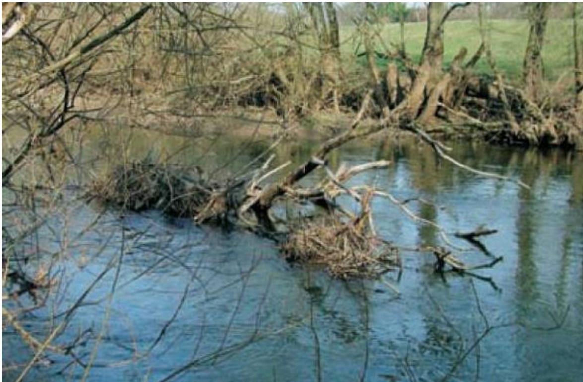
Abbildung 1: Beispiel für die Einbringung von Totholz, Quelle: Bayerisches Landesamt für Umwelt
