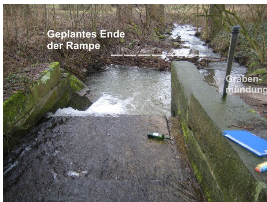
Abb. 3: Blick vom Absturz nach Osten mit Grabenmündung (rechts) und geplantem Ende der Rampe
