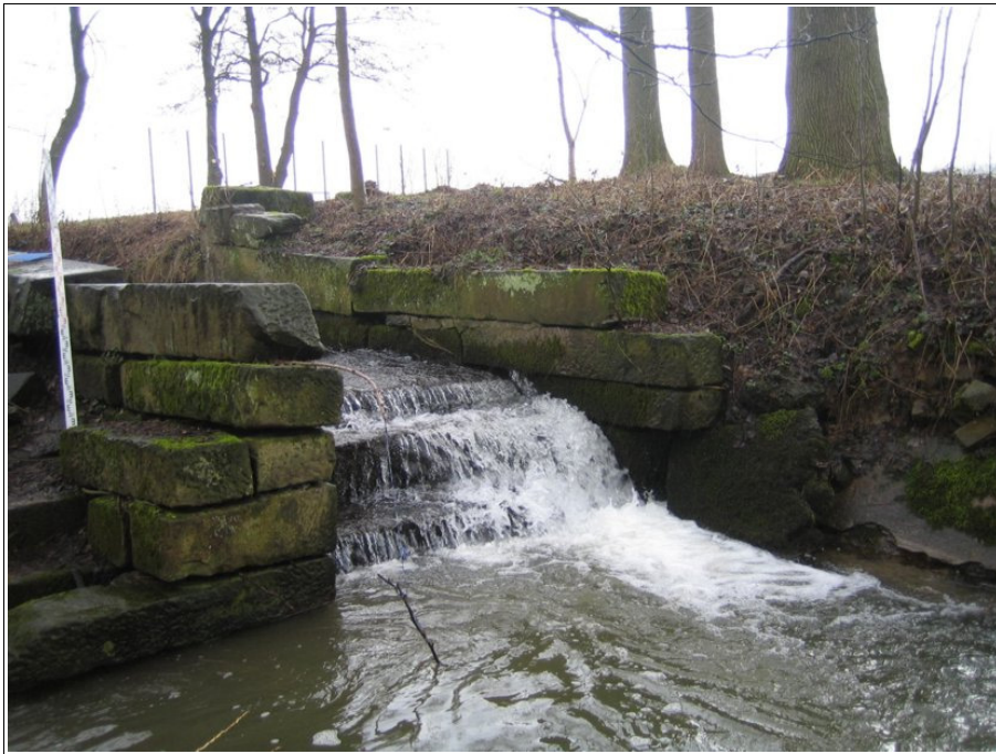
Abb. 1: Sohlabsturz im Brünninghäuser Mühlbach
