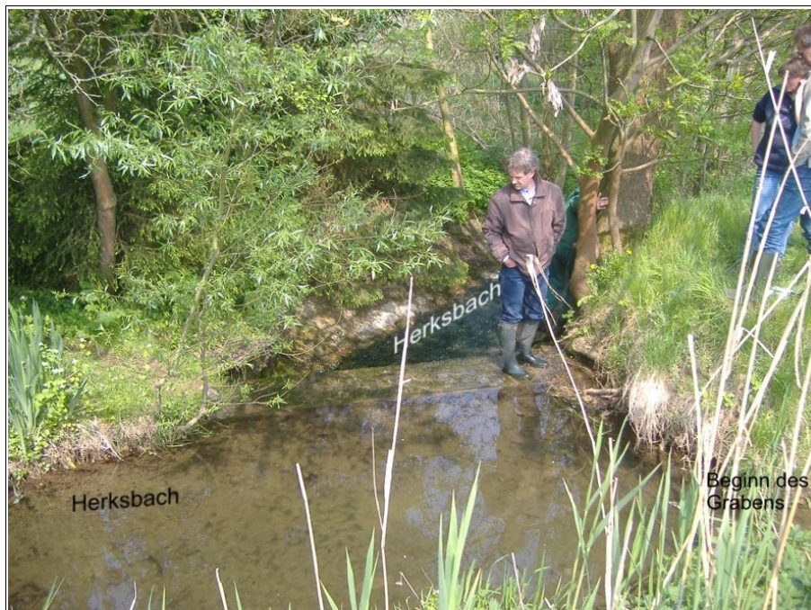
Abb. 1: Wehr im Herksbach und Grabenbeginn (Blick in Richtung Norden, 29.04.2009)
