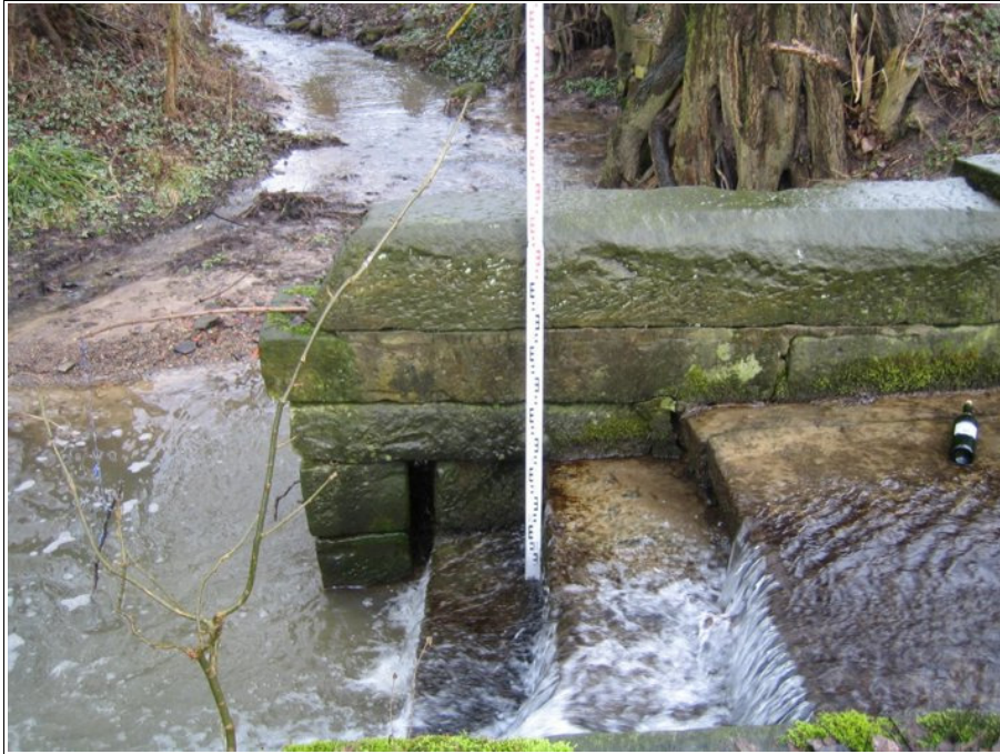
Abb. 4: Situation mit dem einmündenden Graben direkt unterhalb des Absturzes
