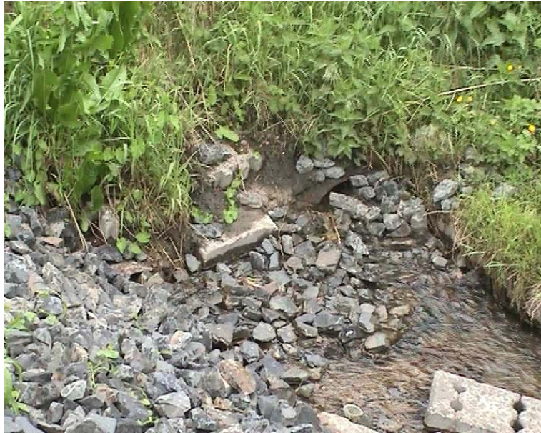
Abb. 19: Auslauf der Durchörterung Börnicker Chaussee (2005)
