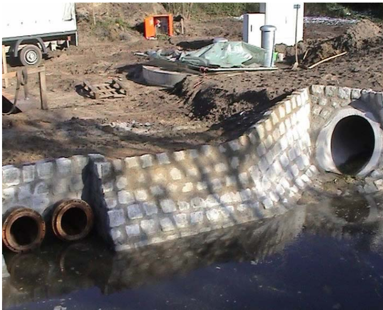
Abb. 27: Bauarbeiten für die Ausläufe des Sandfangs
