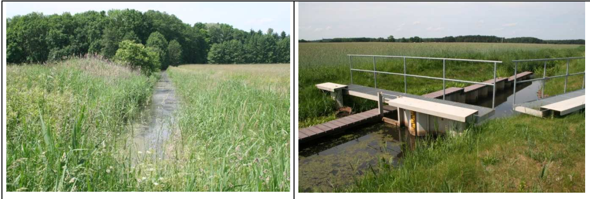
Abbildung 17: Fließ oberhalb Leibchel und sanierter Bohlentau mit FAH
