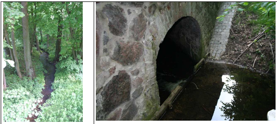
Abbildung 13: Blabber Graben oberhalb Ahrensdorfer See und Messwehr an der L 42
