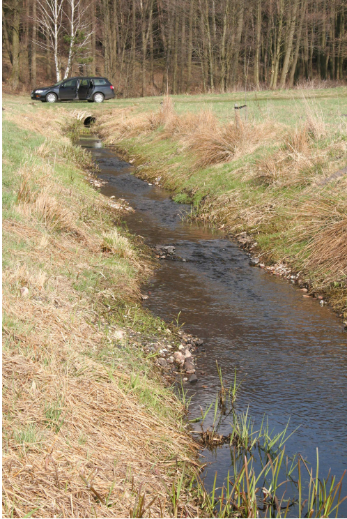
Abbildung 62: Sohlensicherung an einer geöffneten Verrohrung in Form einer Rausche – Kolk – Gestaltung aus Kiessubstrat
