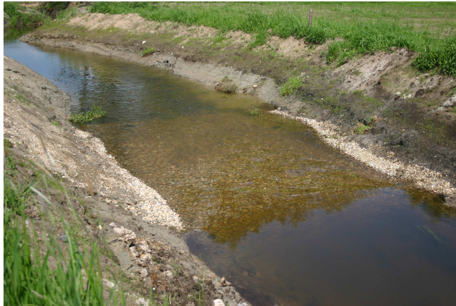
Abbildung 60: Kiesriffle (Bauzustand)
