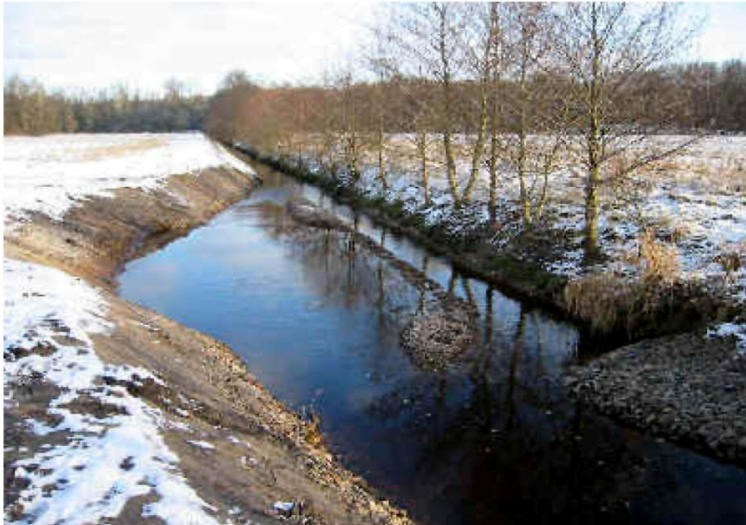
Abb. 6.3 Umsetzungsbeispiel Sandfang mit parallelem Fließgerinne; Quelle: infoNet Umwelt (2005)
