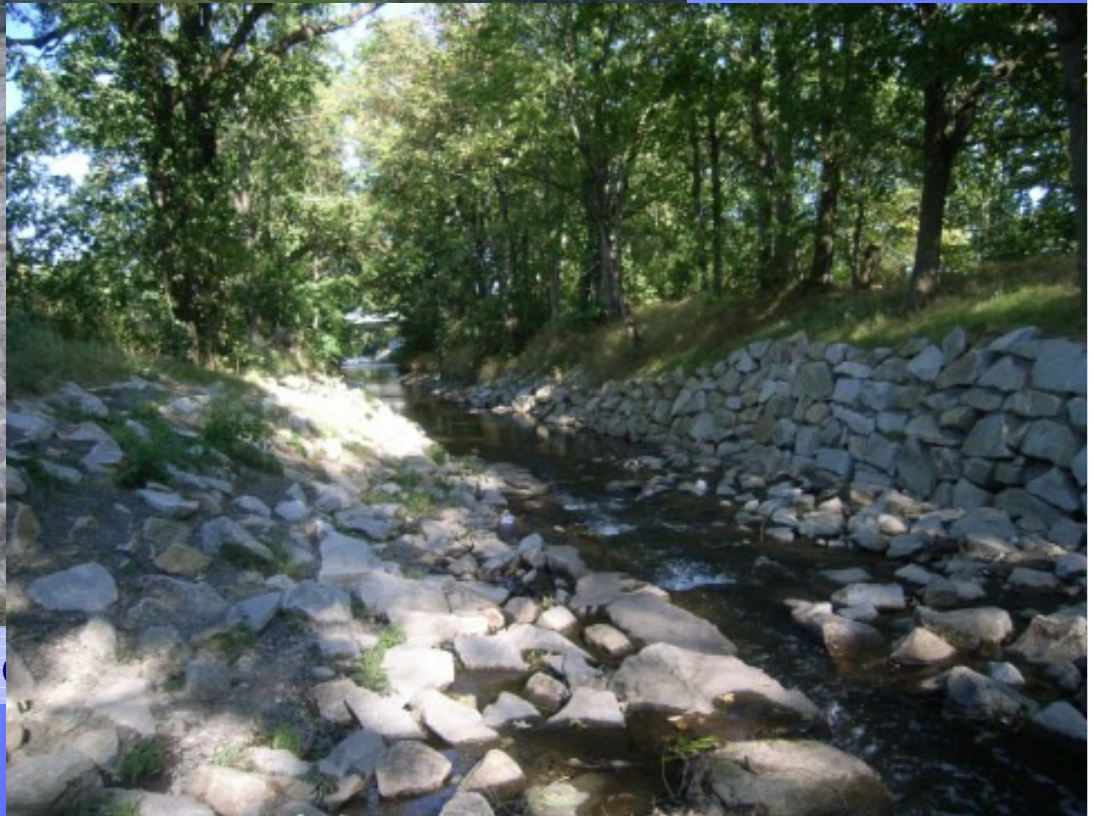
Uferverbau an der Holtemme
