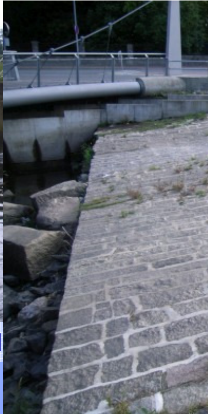
Sohlbauwerk an d
