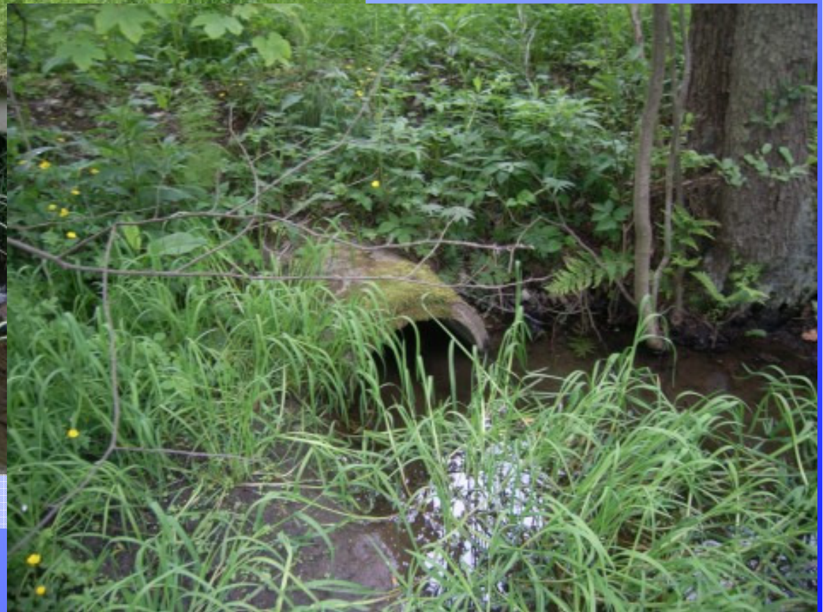
Verrohrung der Selke
