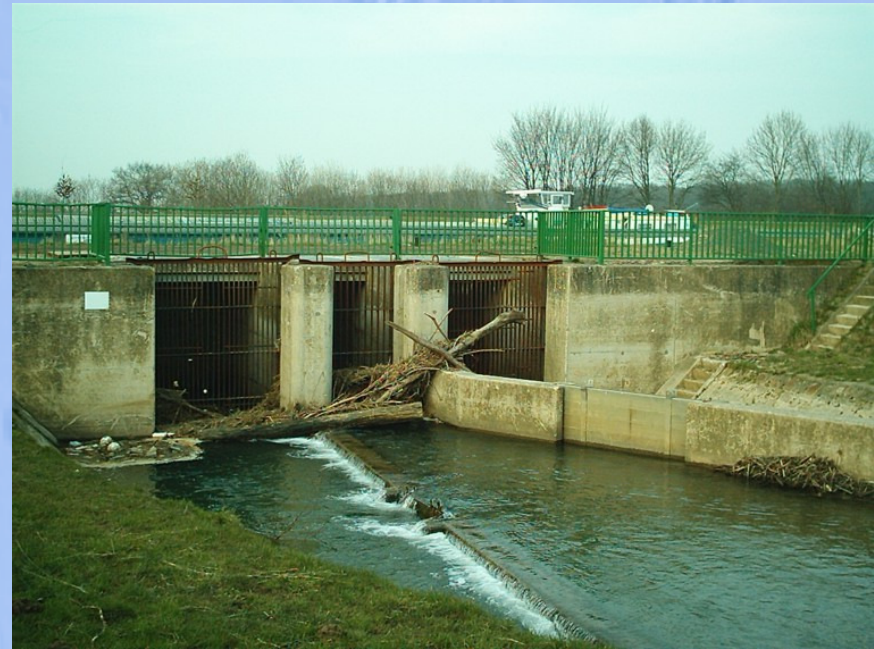
Sohlbauwerk S 87/1 (KP)
