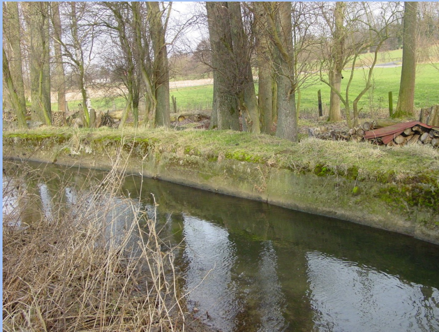
Uferbauwerk U 38/1 (KP)
