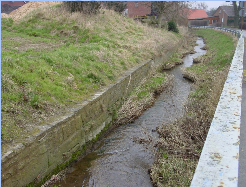
Uferbauwerk U 12/1 (KP)
