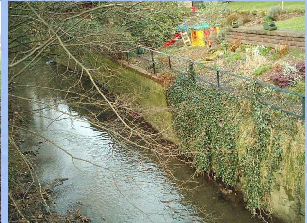
Uferbauwerk U 32/1 (KP)
