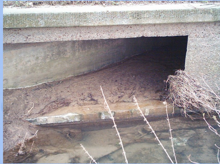
Uferbauwerk U 15/1 (KP)
