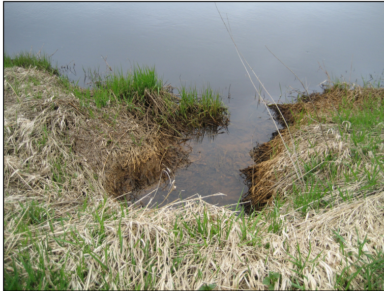
Abb. 2.3 Alte Ise, km 2,600 (Einlauf)
