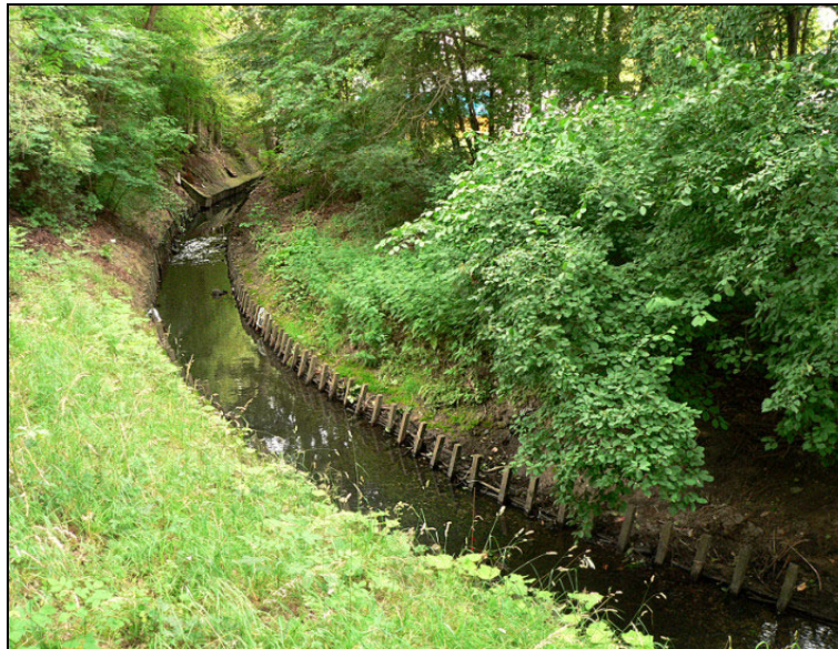
Abb. 6.3 Mit Faschinen kanalisierter Bachverlauf
