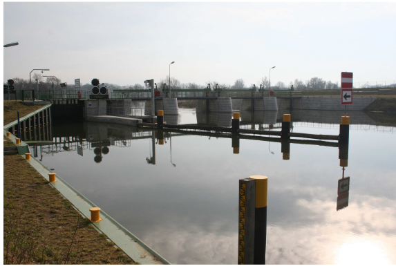
Abbildung 14: Wehranlage Kossenblatt oberwasserseitig
