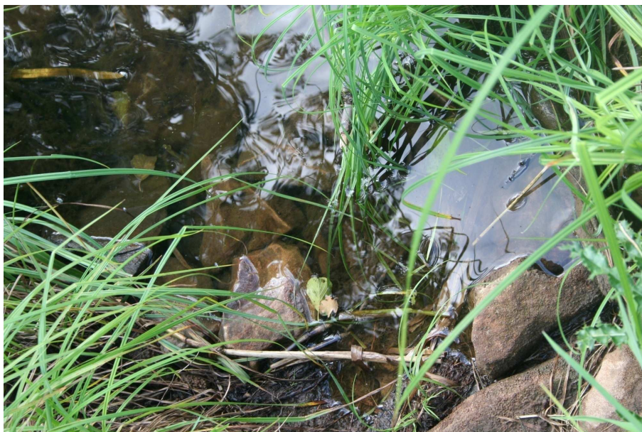
Abbildung 97: Offenes Deckwerk - Steinschüttung
