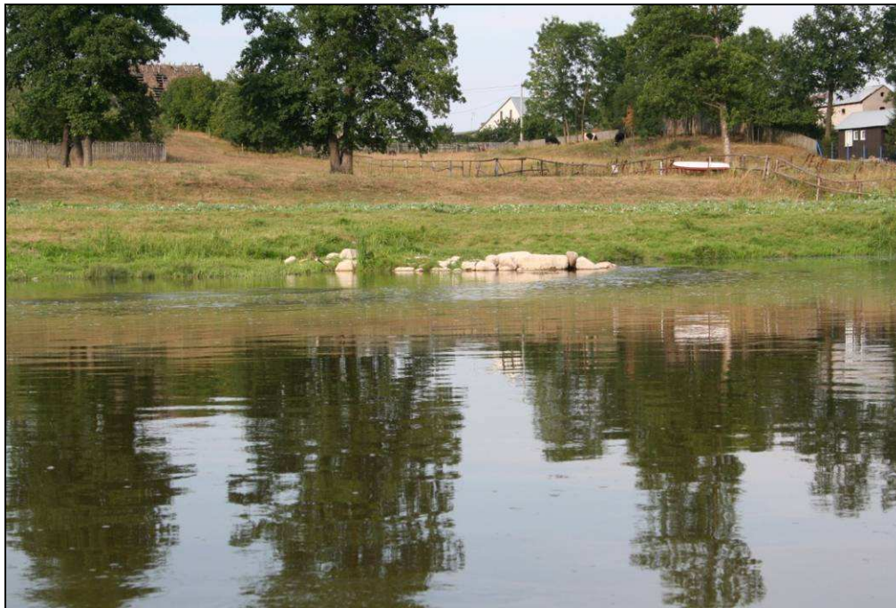
Abbildung 117: Buhne aus Findlingen zur Sicherung des Böschungsfußes am Prallhang im Siedlungsbereich
