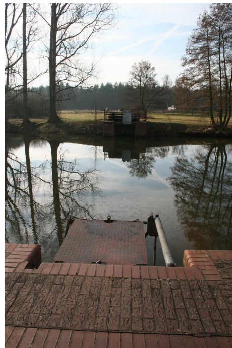
Abbildung 12: Nadelwehr Alt Schadow (ohne gesetzte Nadeln)
