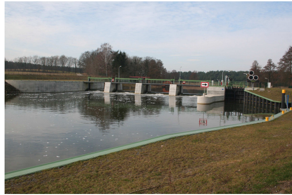
Abbildung 15: Wehranlage Kossenblatt unterwasserseitig
