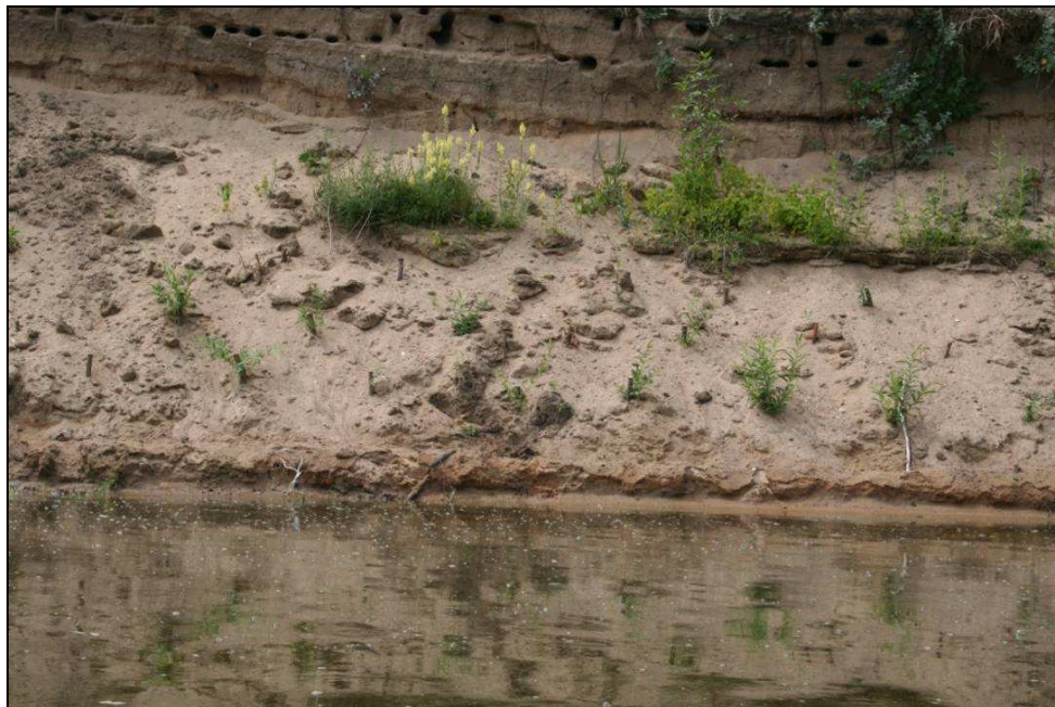
Abbildung 119: Uferverbau mit Steckhölzern
