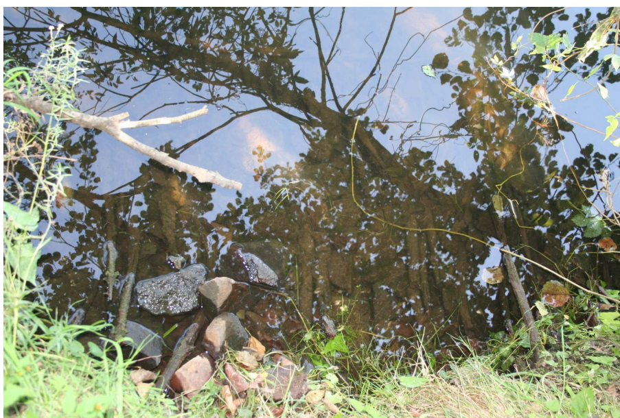
Abbildung 98: Offenes Deckwerk – Steinschüttung über Faschinenverbau
