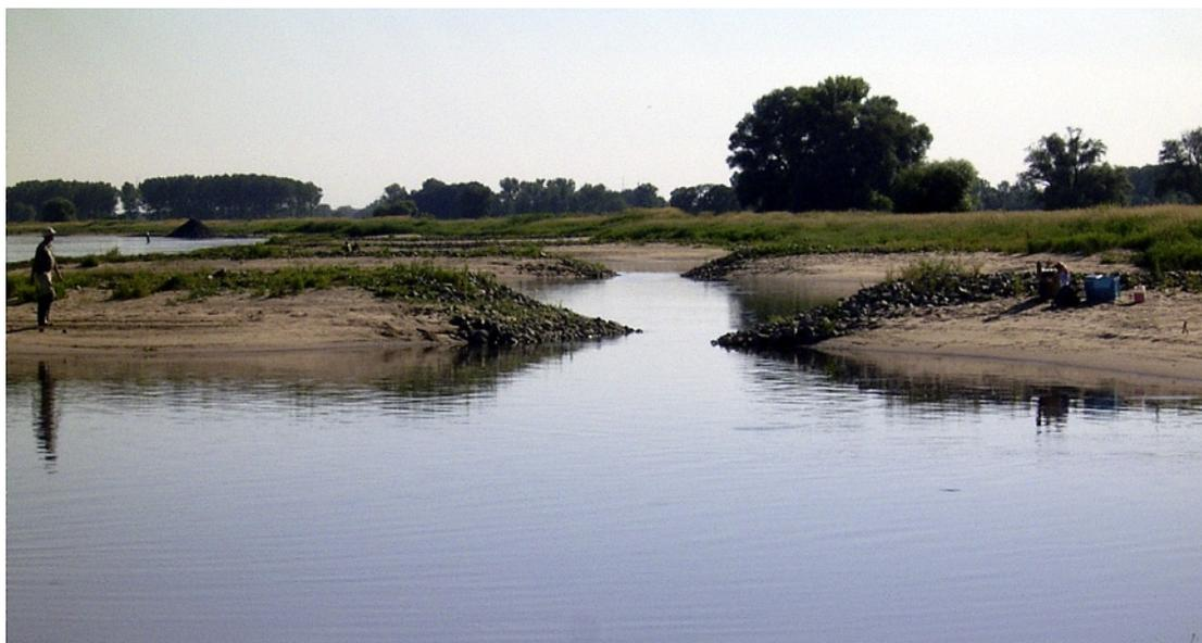
**Abbildung 8: Kerbbuhnen an der Elbe (Quelle: Anlauf, BfG)**
