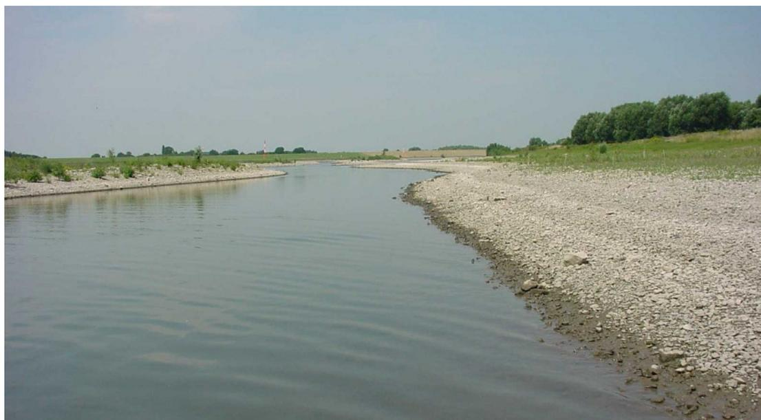
Abbildung 7: Parallelwerk im Rhein bei Walsum-Stapp (Quelle: Mockenhaupt, BfG, 2005)
